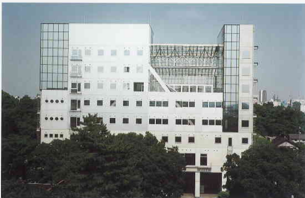
駒場Ⅱキャンパスに新営中の生研研究棟
