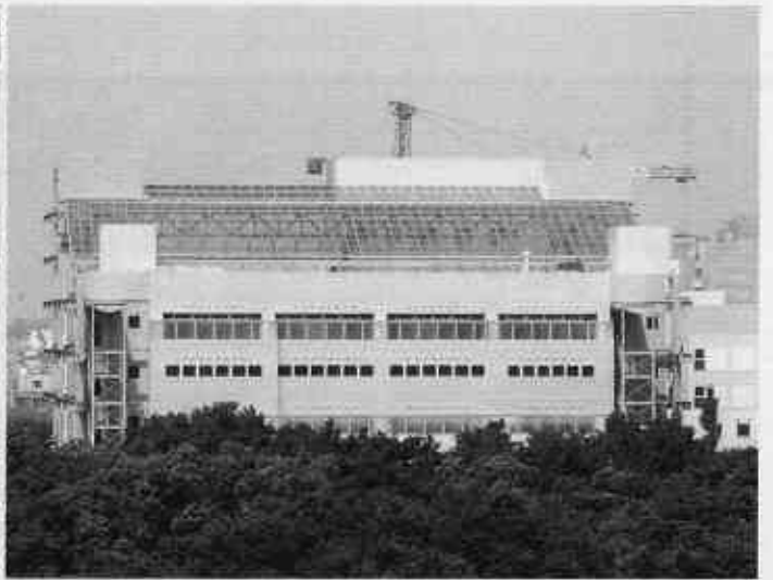
完成間近の生研C棟（全4期工事のうち第Ⅰ期工事分）。C棟内への研究室移転は、平成10年度中にはほぼ完成した。
