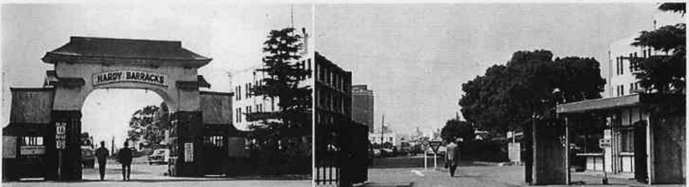
正門改修工事 本所の正門は米軍接収当時のままであったが、池辺教授の設計により改修工事が行われ新しい門(写真右)となった。
