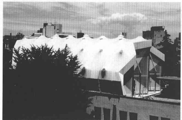
写真1 張る力安定トラス構造外観，
