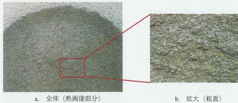
写真4 モルタル吹付け状況
