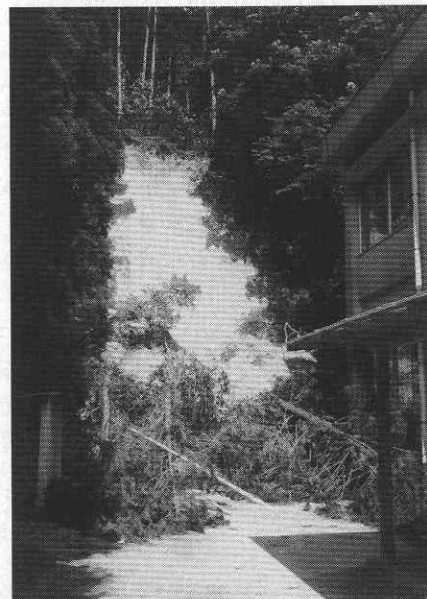
写真 6 平川小学校裏手の斜面崩壊
