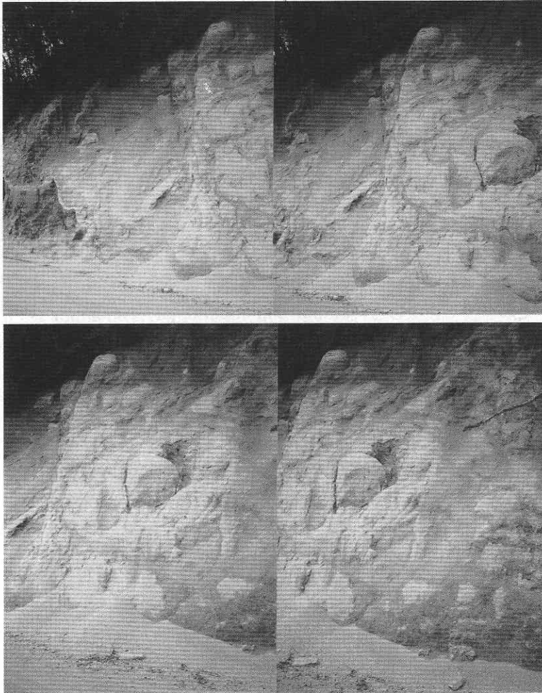
写真2 風化花崗岩の滑り面
