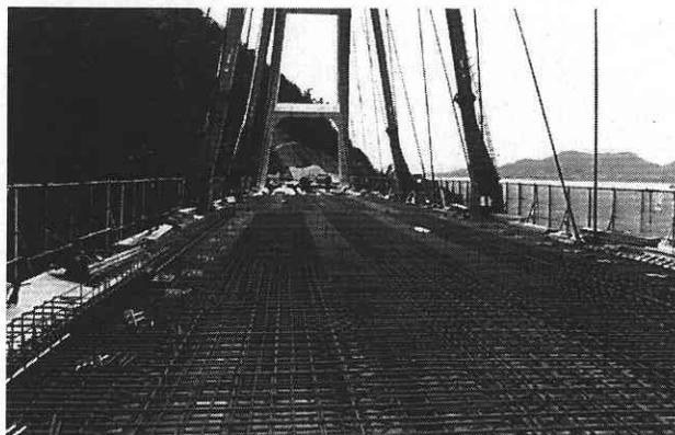
写真 3 エポキシ樹脂塗装鉄筋で施工された内海大橋の床版
