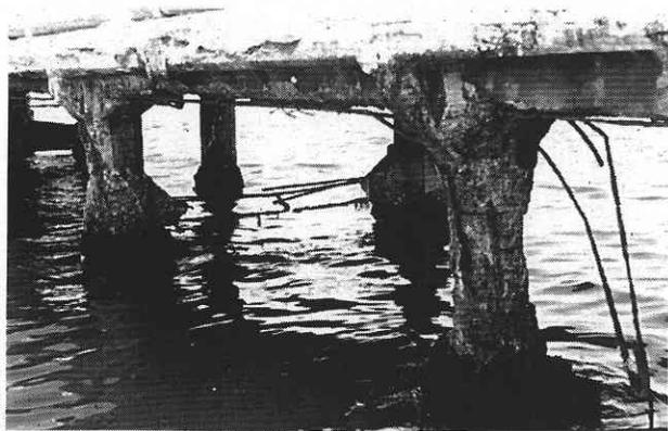
写真 2 凍結融解と塩化物による鉄筋腐食が生じた栈橋の例
