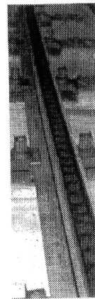
図1 (a)レール上に発生した波状摩耗
