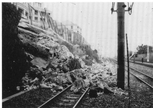
写真1 石積み擁壁の被害例 (JR 摂津本山～住吉駅間)
