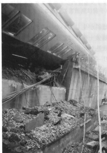
写真3 重力式擁壁の被害例 (阪神石屋川駅付近)
