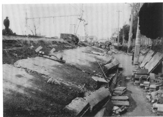
写真2 もたれ式擁壁の被害例 (JR 摂津本山～住吉駅間)
