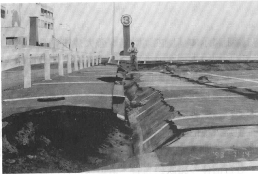
写真10 函館港東日本フェリーターミナル (左：地震直後の液状化被害，右：修復後)
