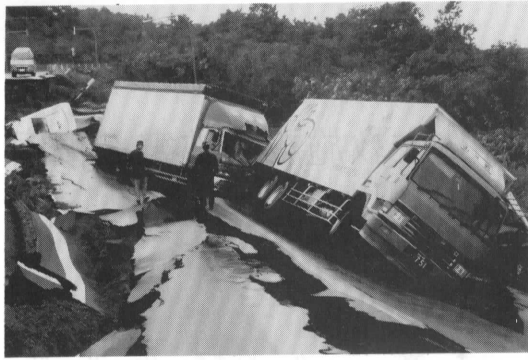
写真9 国道5号線 (左：地震直後の斜面崩壊による路面陥没被害，長万部消防署提供，右：修復後)
