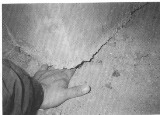
写真6 床の東立ての移動 (津郡郡T中学)
