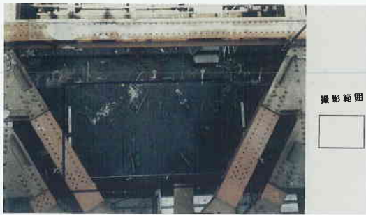
写真1 上床版の外観
