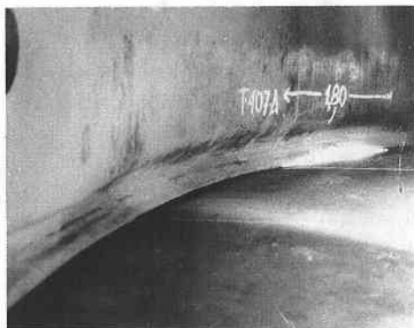
写真3 チリ・コンコン地震（1961年）におけるエレファントフット・バックリングの内面からの写真、コンコン製油所から武藤 清先生を経て入手した報告書による。
