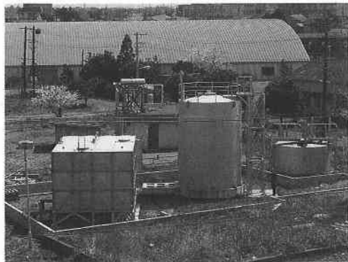
写真2 千葉県実験所科学プラント自然地震応答観測モデル（1985年頃）、1971年~1990年のデータが主なもの、最初は一般研究Bによる施設が主体。
