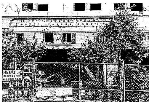
写真 4 鉄骨ブレースによる補修中のRC造ホテル (El Palomar Inn, サンタクルーズ)
