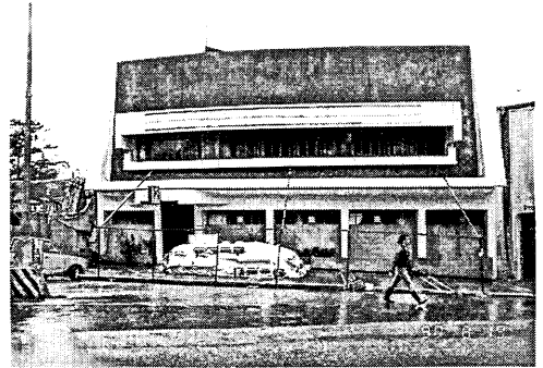
写真7 被害を受けたPILTELの電話局舎
