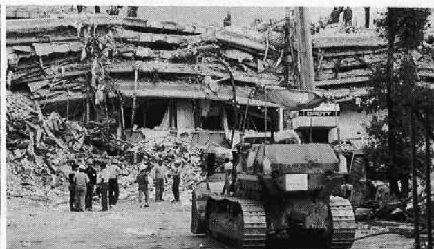
メキシコ地震調査 1985年9月19日メキシコ太平洋岸に発生したM=8.1の地震被害調査と復旧のため、ERSグループが活躍した。(写真はメキシコ市中心部における建物の破壊状況)
