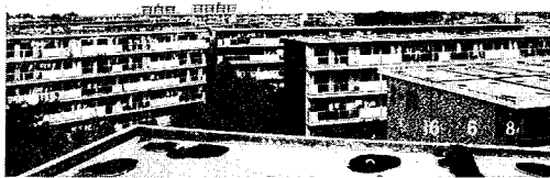
写真-1 調査した集合住宅の全景
