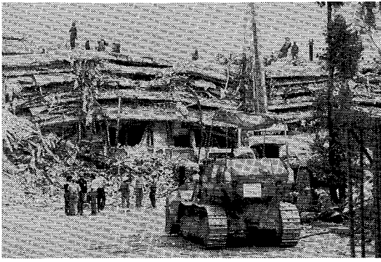
写真 1 パンケーキ破壊を生じた 8 階建の衣類工場 (鉄筋コンクリート平板構造)
