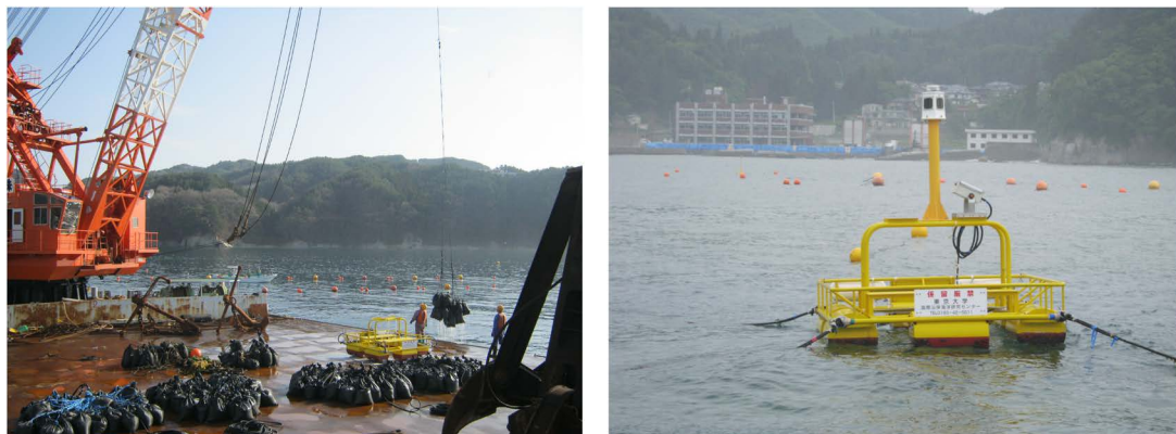
図1 (左) 水温計測装置の設置工事の様子。(右) 国際沿岸海洋研究センターの前に設置された水温計測装置。
