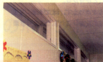
天井に向けて5度傾かせたガラスの欄間
