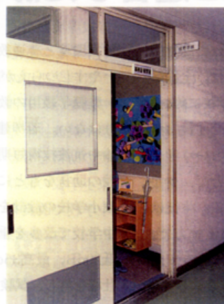
廊下から見た土浦第一中の難聴教室。特別な教室と感じさせないために、既存の建具の内側に防音ドアと防音サッシを追加した。サッシは音を30dBカットできるタイプ。教室内ではスリッパに履き替える
