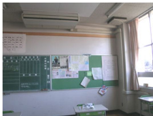
普通教室 E (エアコン)
