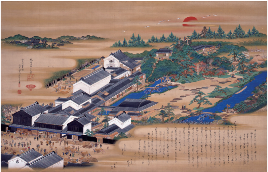
図16 「高崎屋絵図」文京区指定文化財 写真提供：文京ふるさと歴史館
