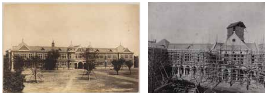
図14 「工科大学本館」「工科大学本館, 施工中」
