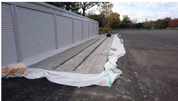
(e) 走行中給電レーンの完成
