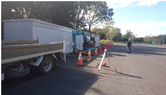
(c) 走行中給電レーンの路盤工事
