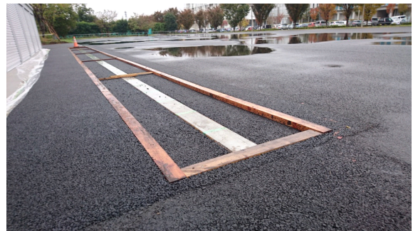
(d) 走行中給電レーンの舗装工事
