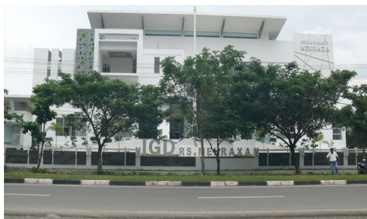
写真 4-20.バンダ・アチェ市内にある震災後に建てられた病院 (住民提供 : 2017 年)
