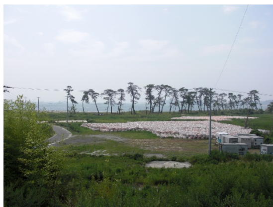
写真 46.桂島の土地整備の状況(筆者撮影)
