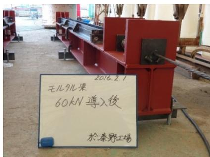
写真-3.1 プレテンション方式での鋼線緊張後の状況
