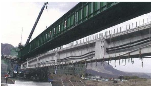
写真-2.13 桁の架設状況
