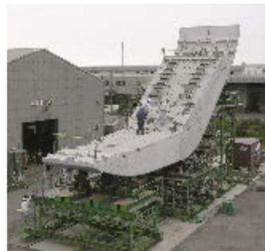
写真-2.4 いわき平競輪場のバンクPCフレーム（現場合せで制作）
