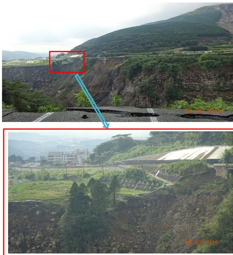
写真-2.10 崩壊した阿蘇大橋近辺の大規模地滑り地域
