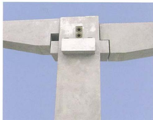
写真-2.8 柱・梁の圧着接合
