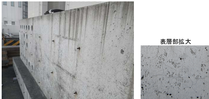
(b) 木製型枠による部材
