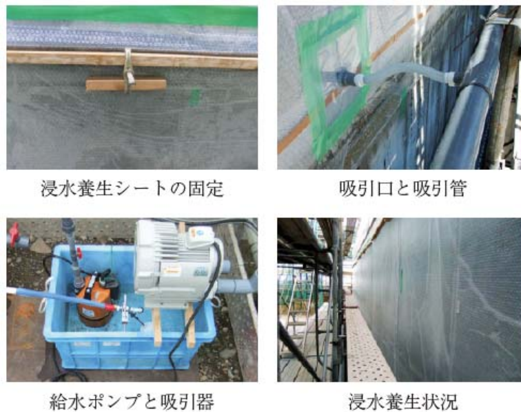
写真 2.3.1 浸水養生システムの構成 12)
