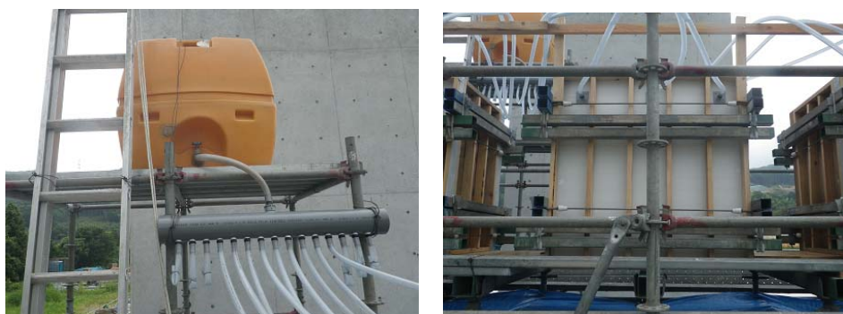
写真 5.2.2 湿潤養生の状況
