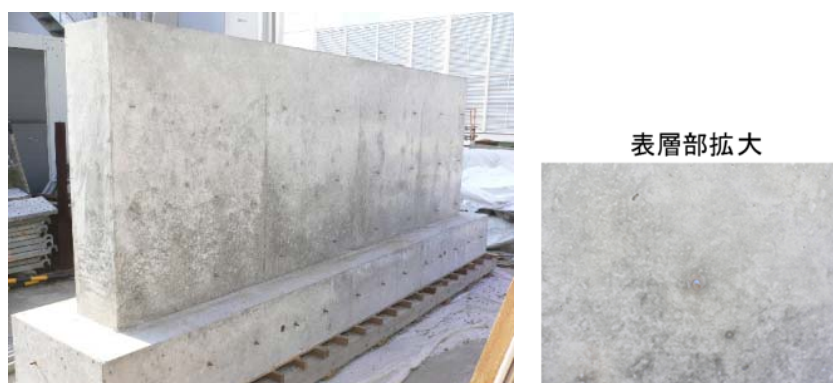
(b) 木製型枠による部材
