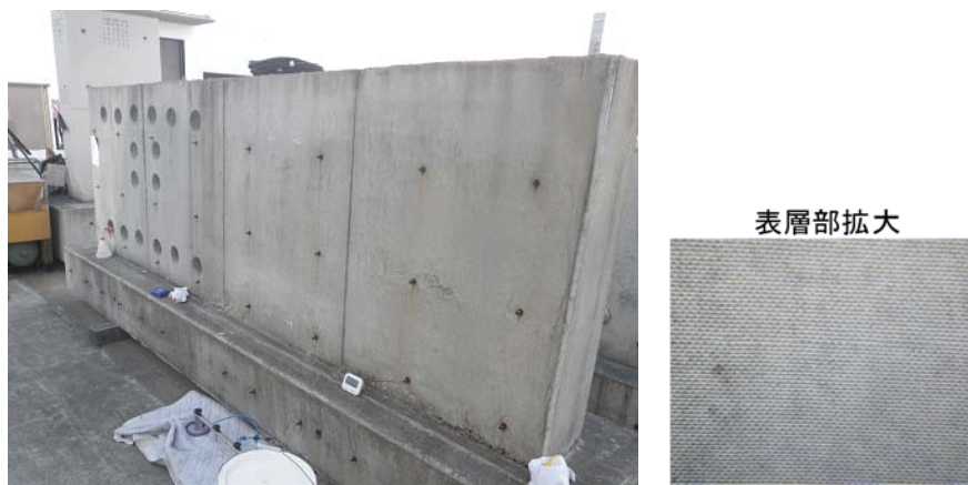
(a) 排水湿潤連続養生を実施した部材
