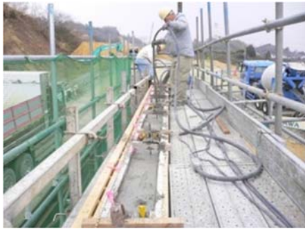
(a) コンクリート施工状況
