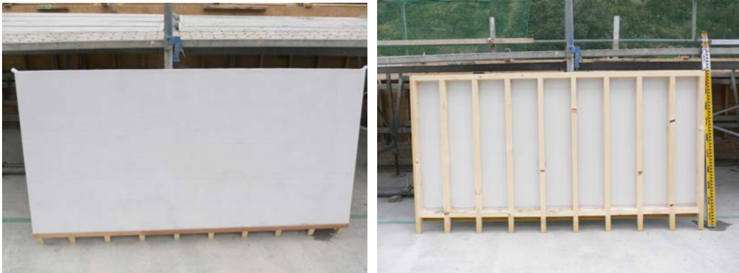
写真 3.2.4 排水湿潤連続養生に使用する型枠の外観
