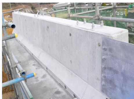
(a) 木製型枠
