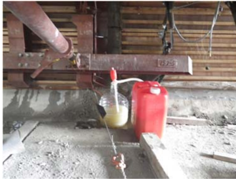
写真 5.3.2 余剰水の排出状況 (排水量：2.59kg/m 3 )
