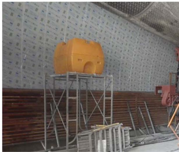
写真 5.3.3 湿潤養生の実施状況
