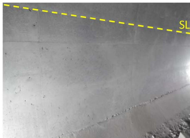
(b) 鋼製型枠部
