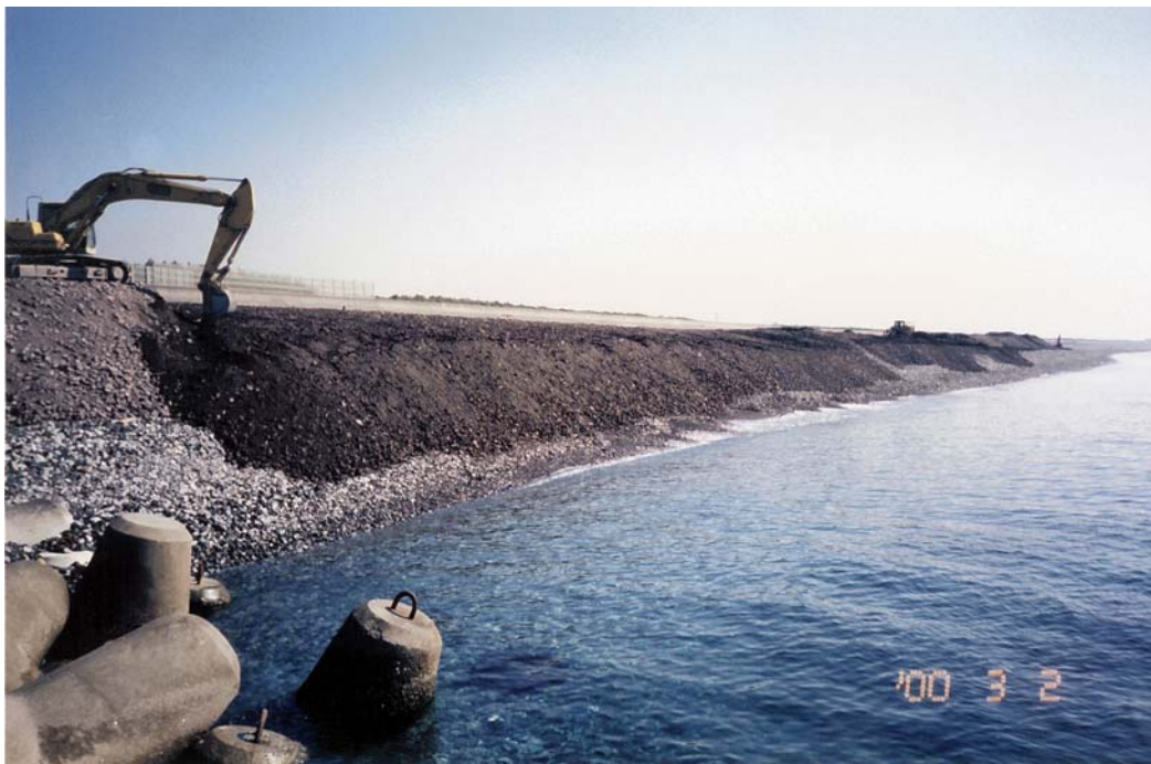
写真-2.3.1 昭和放水路東側の陸上養浜の状況(2000年3月2日)
