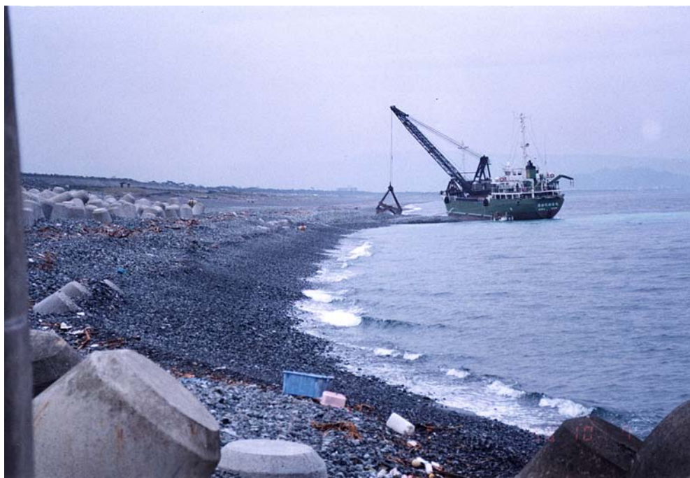
写真-2.3.2 昭和放水路東側の海上養浜の状況(1998年10月7日)
