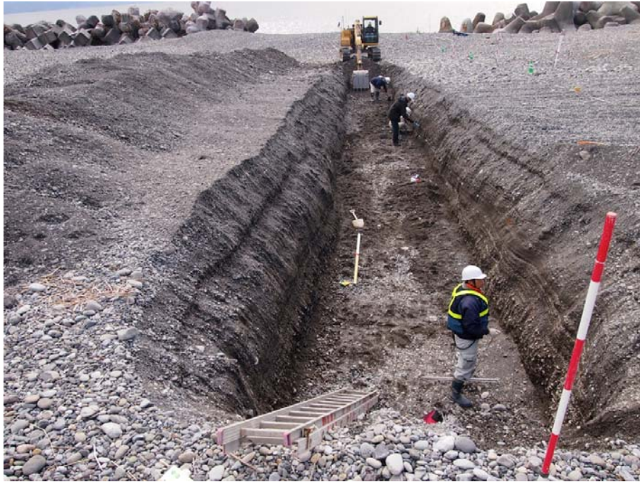
写真-2.1.1 掘削の形状（2015年2月4日富士海岸 No.51 付近）
