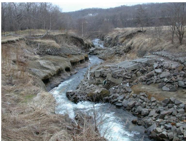
図 3 - 1 - 8 河道直線化に伴う河床低下
