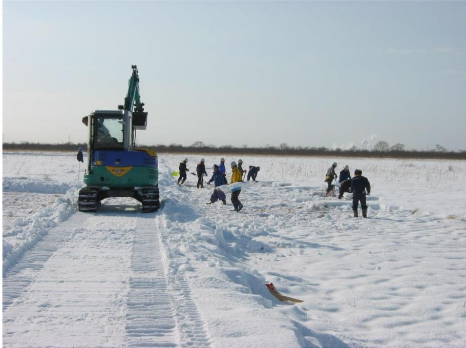
湿原の損傷を防ぐため冬期にアイスブリッジを設けて施工
