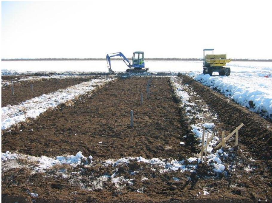
小型の重機により丁寧に施工（地盤掘り下げ試験区整備）
