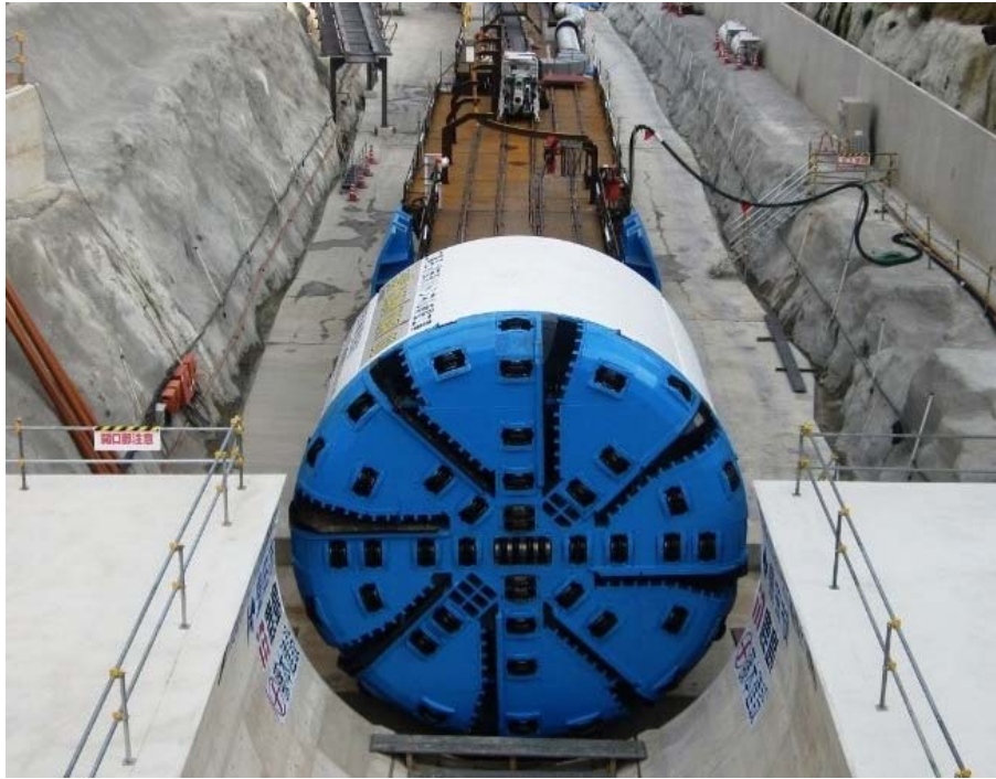
図3-7 先進導坑掘削に使用した TBM（川崎重工製）
