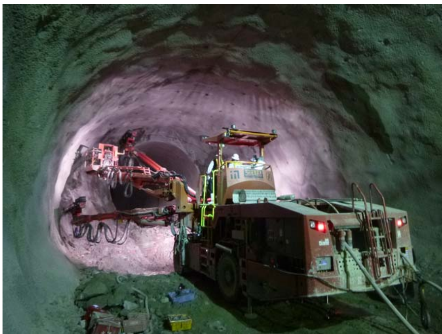
(a) ドリルジャンボ(穿孔機)による発破孔の穿孔状況
