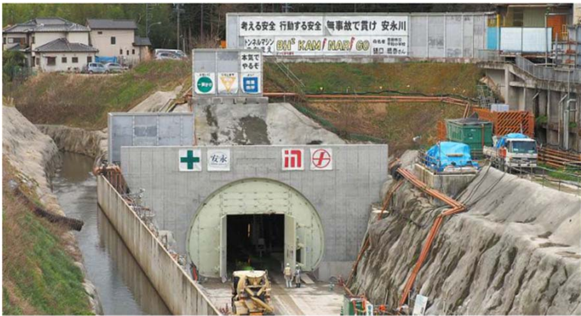
図3-3 安永川トンネル 秋葉側坑口(上流側)
