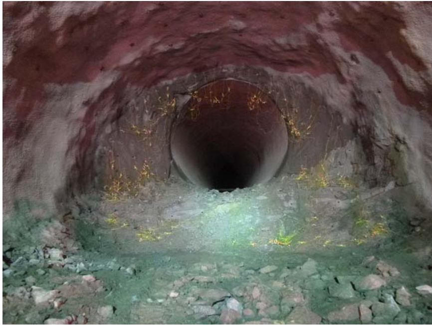
(c) 装薬・結線完了状況
