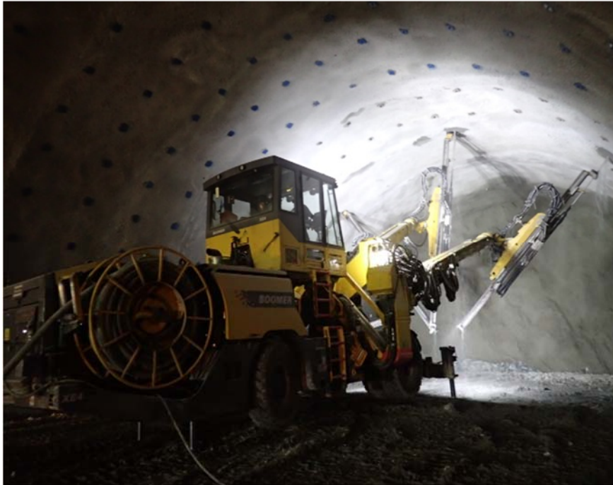
図 5-12 白井トンネルで適用したコンピュータジャンボ (アラスコプロコ社製 XE40)
