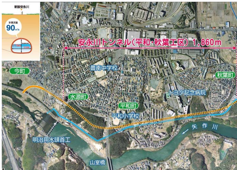
図3-1 安永川トンネル 航空写真 (豊田市河川課, 2015c)
