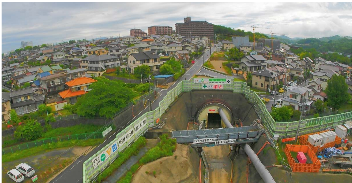
図3-4 安永川トンネル 水源側坑口(下流側)
