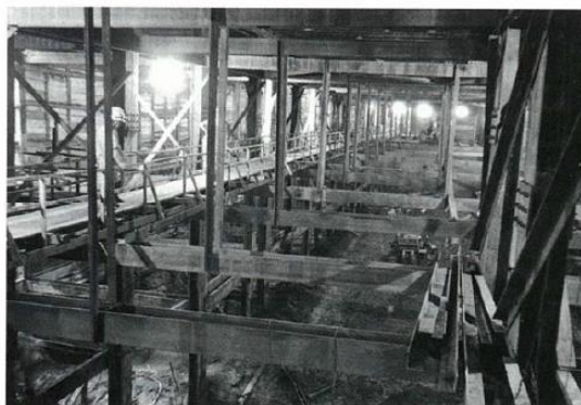
写真 4-2-1 開削工法の掘削状況
