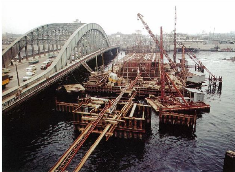
写真 4-2-4 河川中央部潜函工事状況
