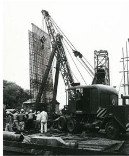
写真 4-2-3 イコス工法の鉄筋籠の 建込み状況
