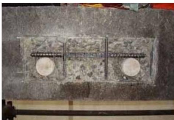
写真 6-2-1 犠牲陽極材を埋設する方式
