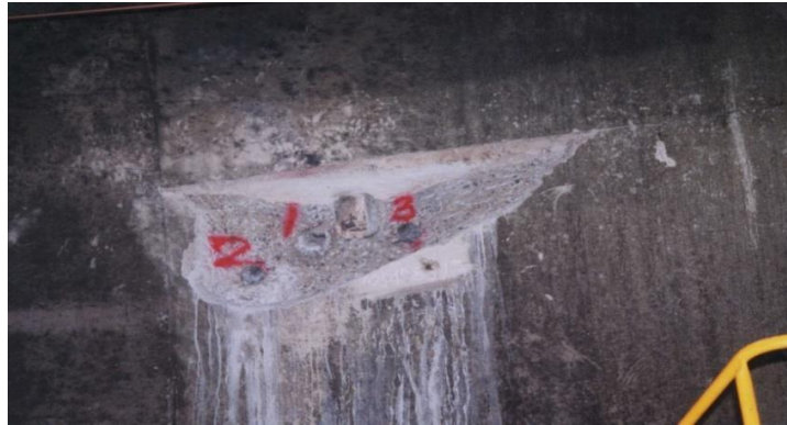
写真 2-1-1 福岡トンネルのはく落跡 14)
