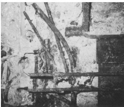
写真 2-3-1 香港地下鉄トンネルの塩害 36)
