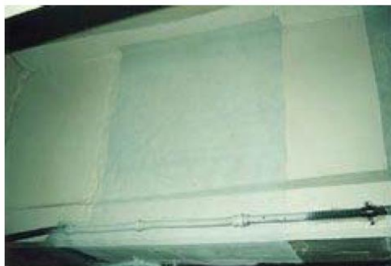
写真 6-2-2 犠牲陽極材を貼り付ける方式
