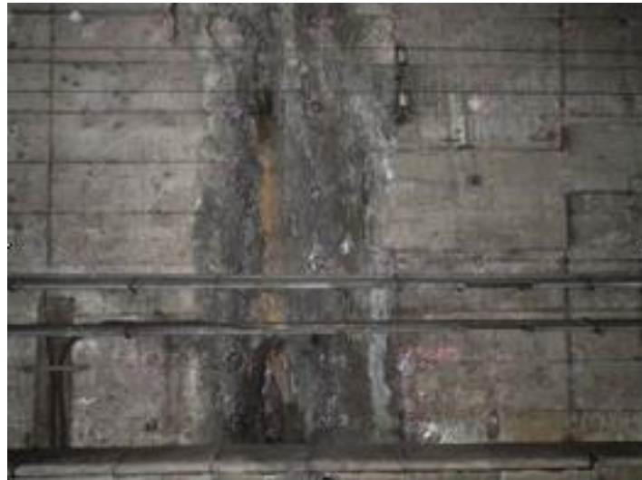
写真 5-2-3 試験実施箇所の漏水状況 (半蔵門線 日本橋川下)
