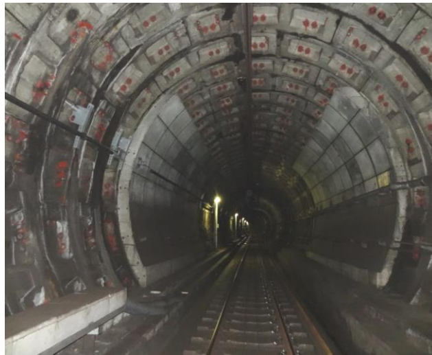
写真 2-3-5 塩害を受けた感潮河川下のシールドトンネルの二次巻き補強工事 54) 55)
