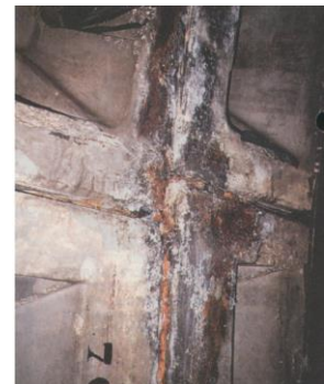
写真 2-3-2 エジプト道路トンネルの塩害 37)
