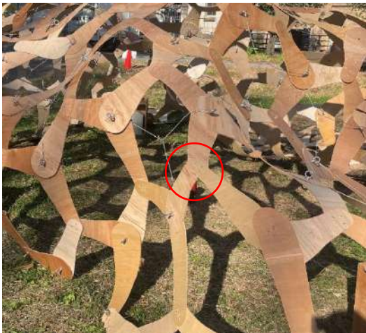
図 110 合板の割れが生じた箇所
