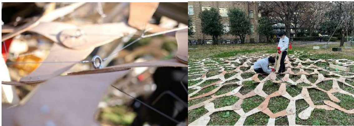
図 91 ユニット同士の接合部（左）、現場でワイヤーに張力を入れる作業（右）
