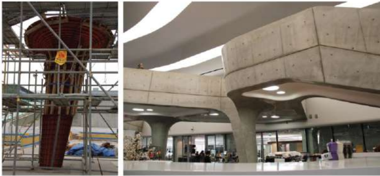
図 37 MPSF Machine で制作した PC 鋼製型枠 109
