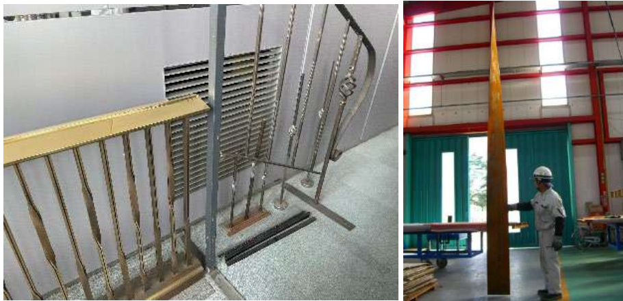
図 41 K 社の手すりのツイスト加工（筆者撮影）、ツイスト加工したルーバー 122
