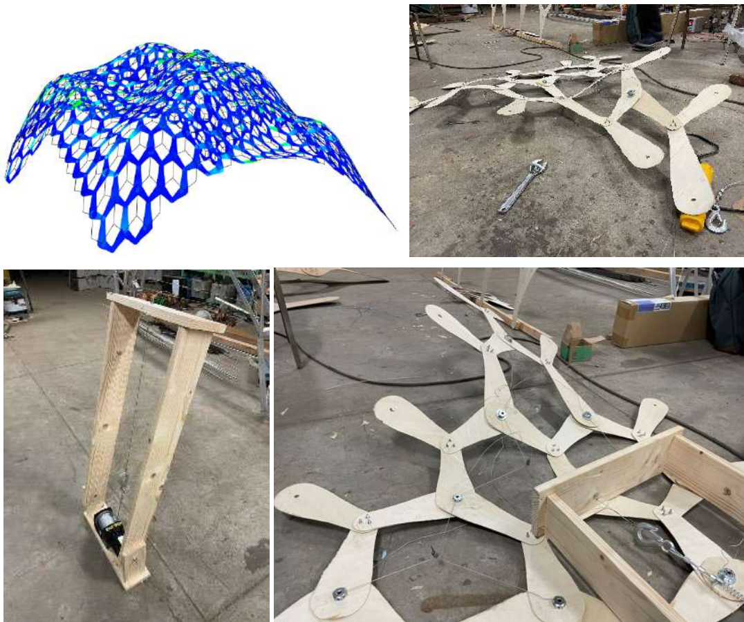
図 67 形態: 三又ユニット分割による最大曲率 0.72 \text{ [rad/m]} の二次曲面 / 素材: ラワンベニヤ(4mm) / 道具: ワイヤー+ワイヤー巻き取り機
