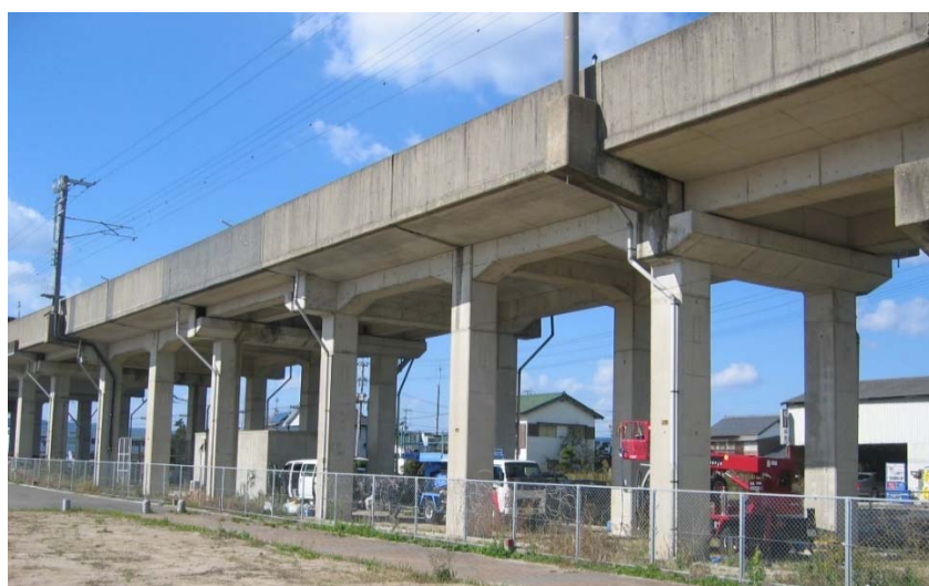
写真 2.2.1 高架橋 A の概況
