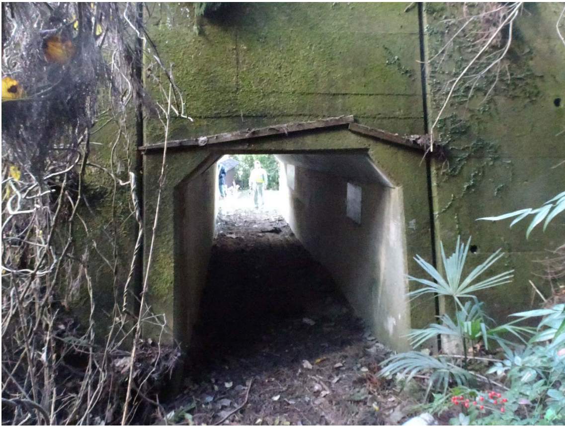
写真 2.2.4 高架橋 D の概況
