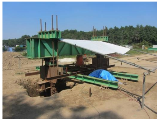
写真-4.1.2 反力杭式試験状況
