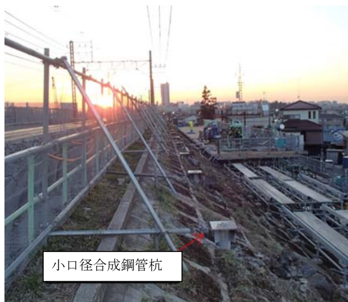
写真-7.3.2 施工完了状況
