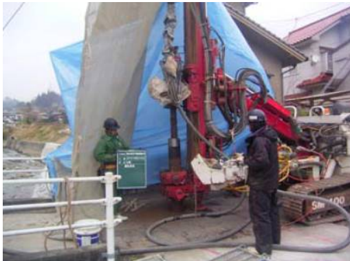
写真-1.2.2 STマイクロパイル工法の施工事例 26)
