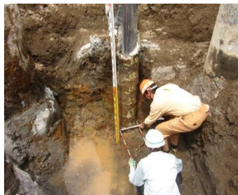
写真-3.10.6 SIV C2 の計測状況 (GL. -2.0m)
