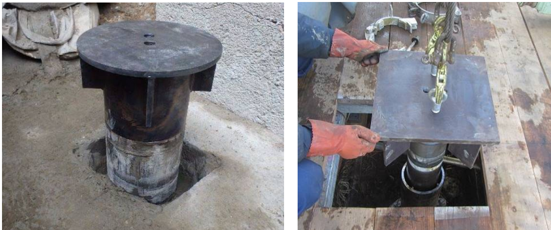
写真-2.2.5 杭頭結合部材（左：円形，右：矩形）
