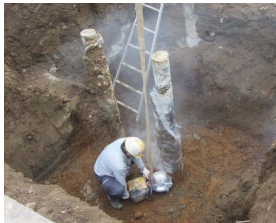
写真-3.11.1 押込み載荷試験杭の試掘調査
