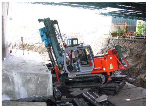
写真-1.2.3 ねじ込み式マイクロパイル工法の施工事例 27)
