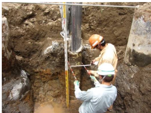
写真-3.10.5 SIV C2 の計測状況 (GL. -1.2m)
