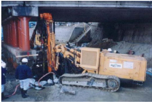
写真-1.2.1 高耐久マイクロパイル工法の施工事例 25)
