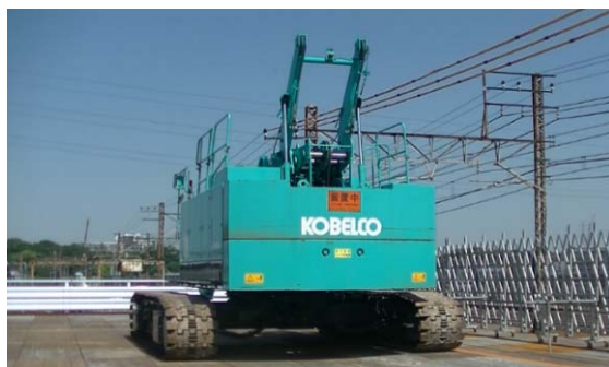
写真-7.4.1 現場計測に用いた 75t クローラクレーン
