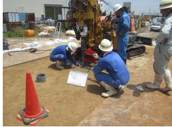
写真-3.6.3 杭先端部の地盤改良状況
