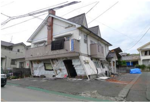
写真 3.1.3 壁の偏心によるねじれ
