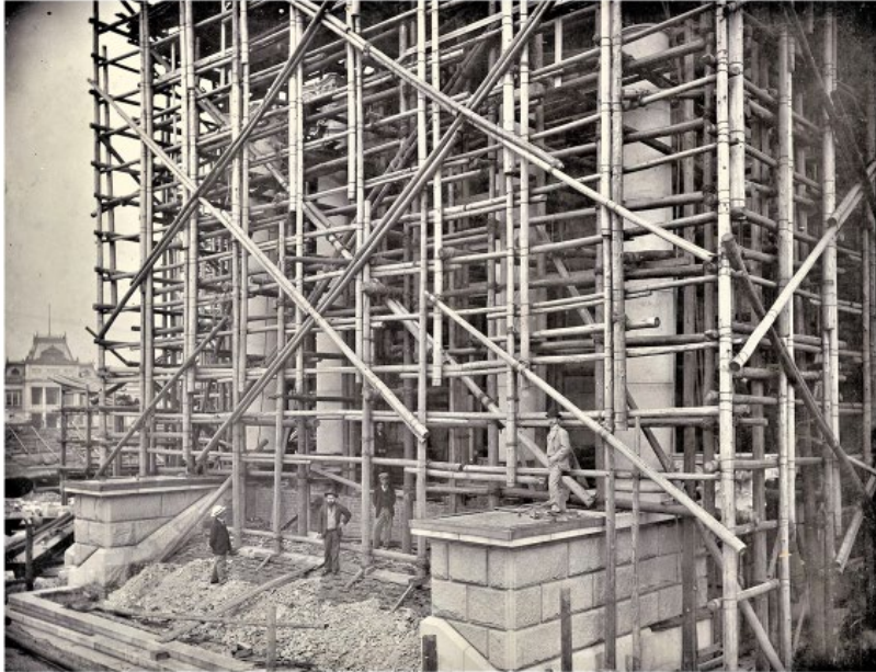
(図5-55) 中之島図書館 工事現場写真
