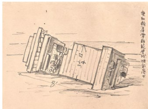
(図2-125) 愛知県尋常師範学校煙突落下
