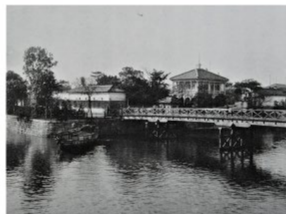
(図3-3) 住友家鰻谷旧本邸 洋館部は 明治12年(1879) 初代・八木甚兵衛の設計施工
