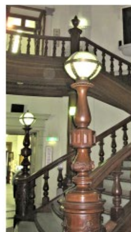
(図5-53) バロック階段手摺親柱の 木彫意匠装飾
