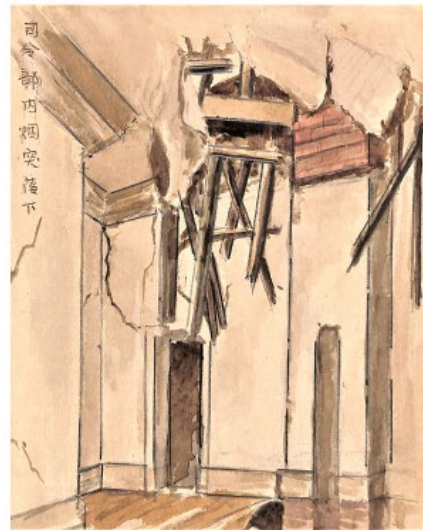
(図2-126) 司令部内煙突落下
