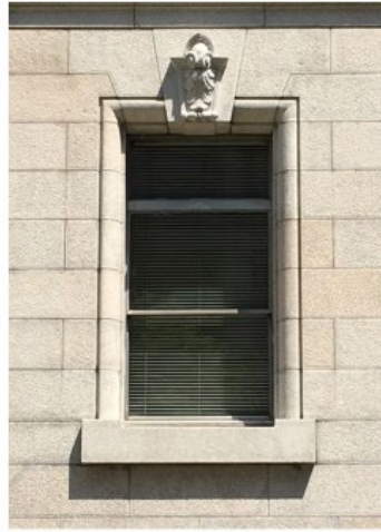
(図5-65) 中之島図書館2階の窓 (1904年) 黄金矩形の深目地が印象的で全体に緊張感がある
