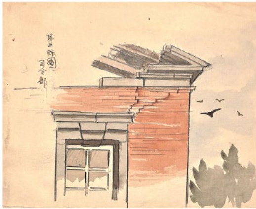
(図2-123) 第三師團司令部 外壁クラック
