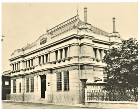
(図5-73) 住友銀行門司支店 明治37年(1904)竣工
