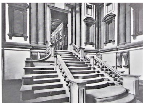
(図5-46) ラウレンティアーナ図書館 玄関ホールと階段
