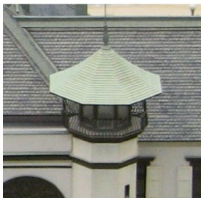
(上 図4-34) 八角塔頂部
