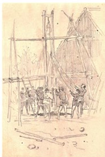
(左上 図1-36) 現在でいうドロップハンマー式の 檣で杭を打つ人々 明治30年頃 (中上 図1-37) 仕事帰りの職人の家族 同上 (中下 図1-38) 地引網を曳く人々 同上 (右 図1-39) 煉瓦工場で働く人々 奥に監査 している野口自身も描いている (左下 図1-40) 井戸で水汲みの少女
