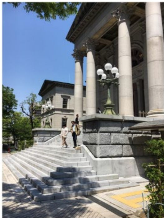
(図5-26) 象徴的に上昇する外部空間
