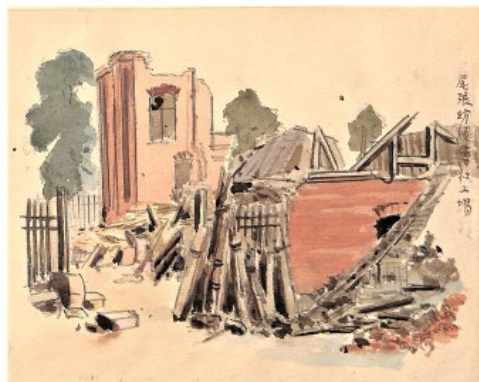
(図2-122) 尾張紡績会社工場 倒壊現場
