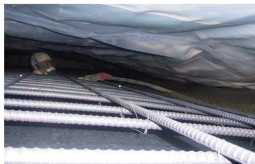
写真 1.3.2 肩部の締固め状況 8)
