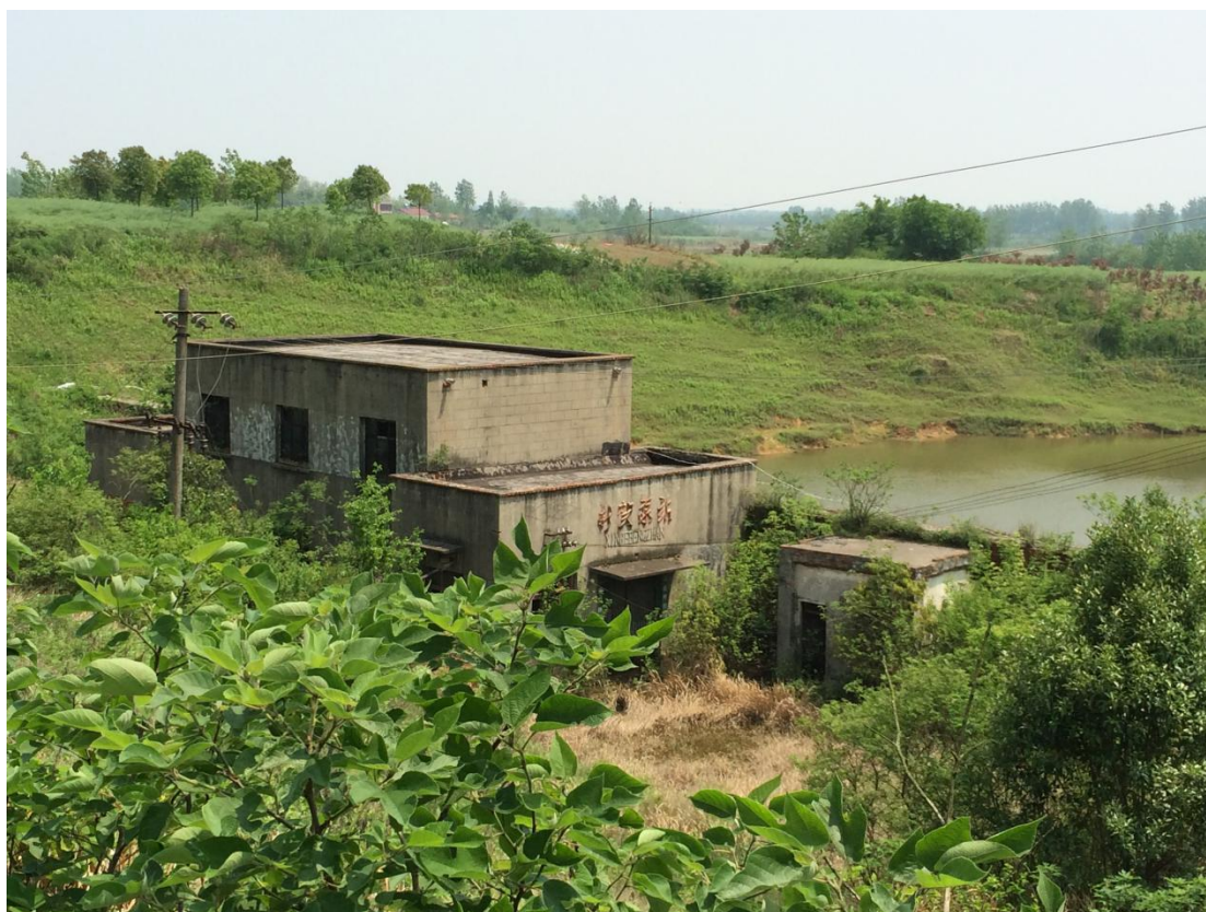
図 6-2 新賀ポンプステーション（新賀泵站）
