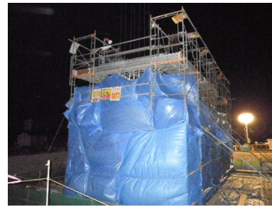
写真-3.4 試験体作製後における養生の様子
