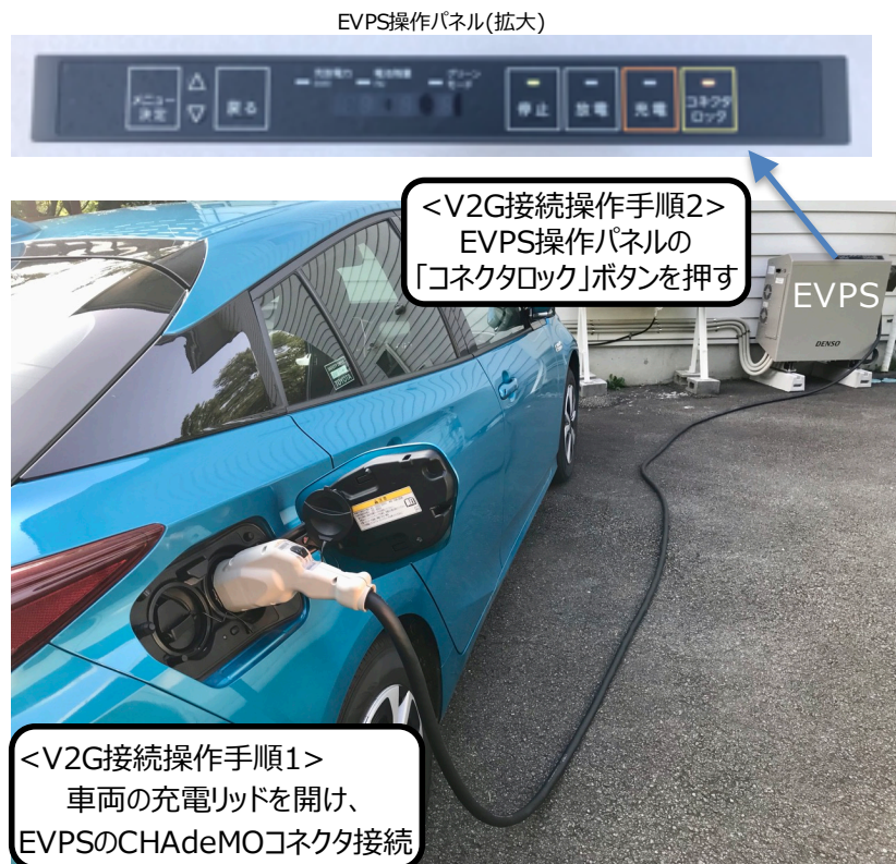
図 7.3 電動車 V2G 接続操作
