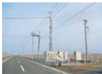
配送電施設の建設
