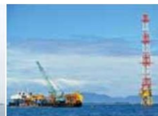
海底ケーブルの設置
