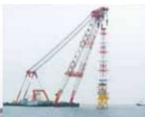
観測塔の建設
