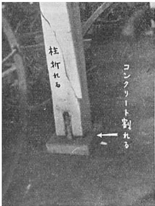
第144圖 根元が緊結されて おて折れた柱 (埼玉縣鴻ノ巣町 某陳列室)
