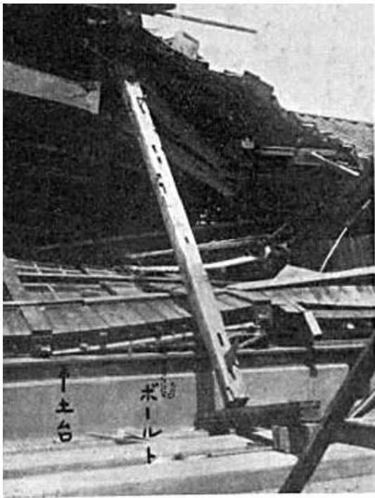
第 141 圖 土臺が緊結されて ゐて倒れた建物 (福岡市 某小學校舎)
