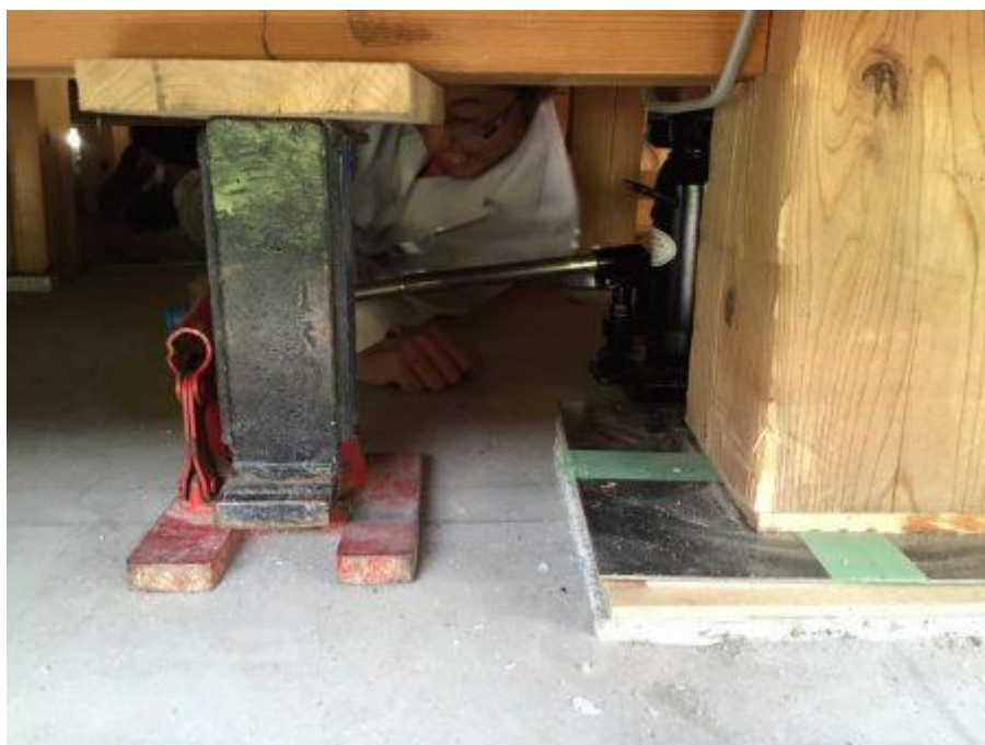
図 4.9.5 伝統構法住宅の『揚げ前』 (写真：文献 66) から一部引用)
