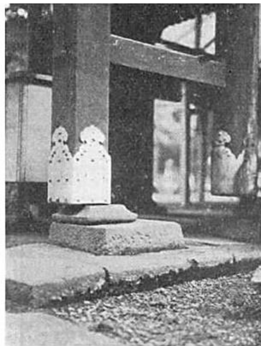
第145圖 根元が移動して 折れなかつた柱 (神奈川縣元箱根村 某神社)
