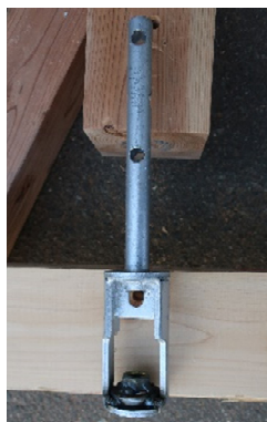
写真 3.9 基礎直結型柱脚金
