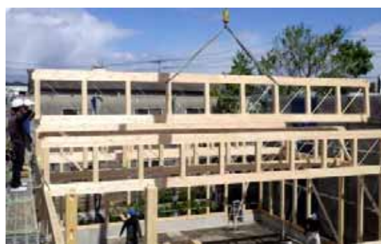
Hトラス 10-M-5 揚重移動
