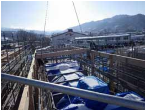
小屋梁(重量梁)揚重取付
