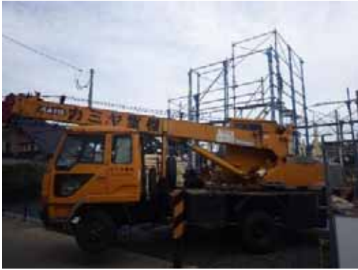
揚重機(トラッククレーン)
