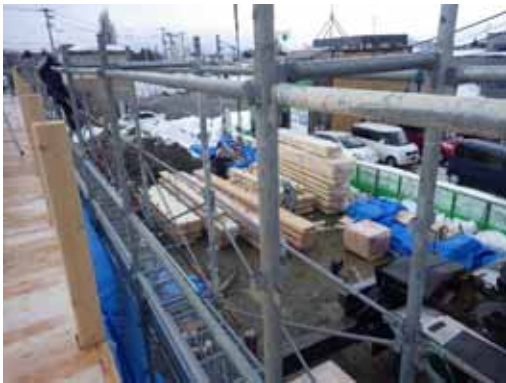
重量梁_地上玉掛け
