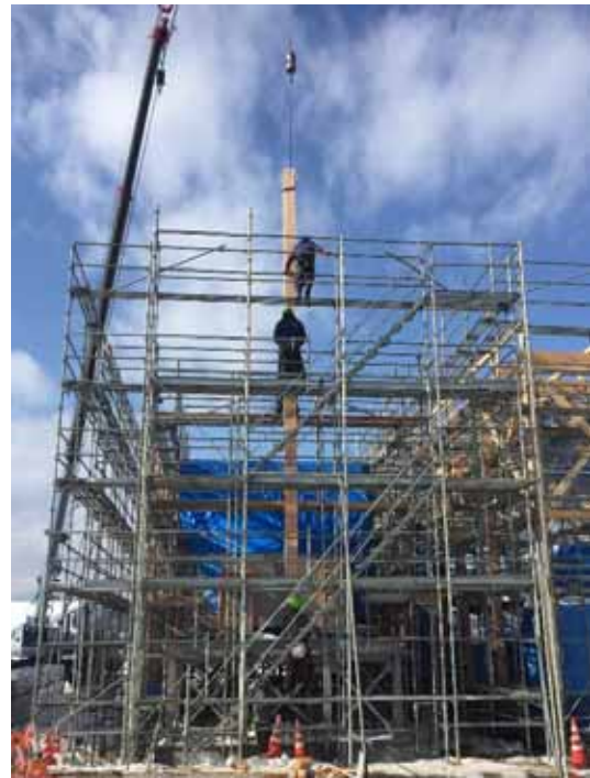
重量柱_揚重取付状況(非住 C)
