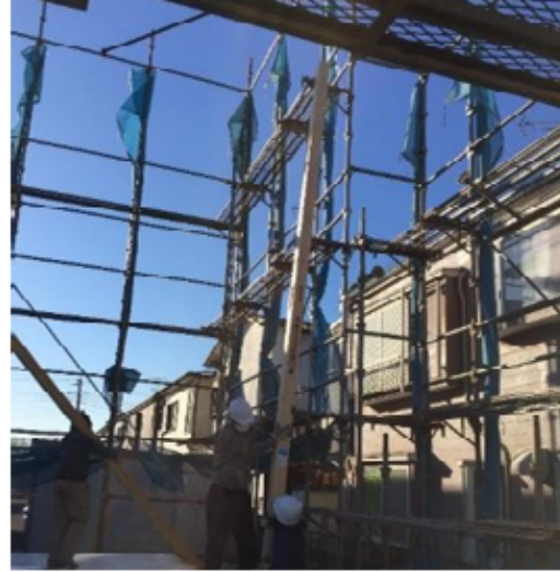
通し柱_人力取付
