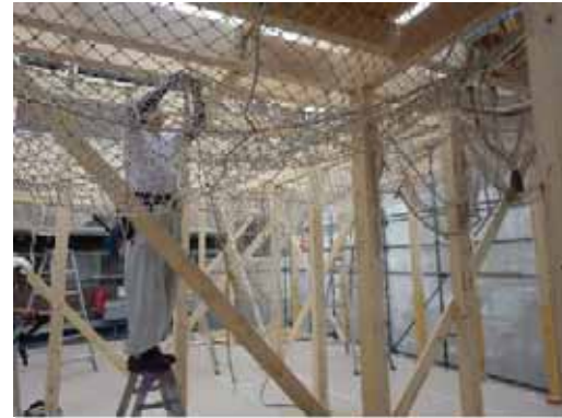
水平ネット取付(2)
