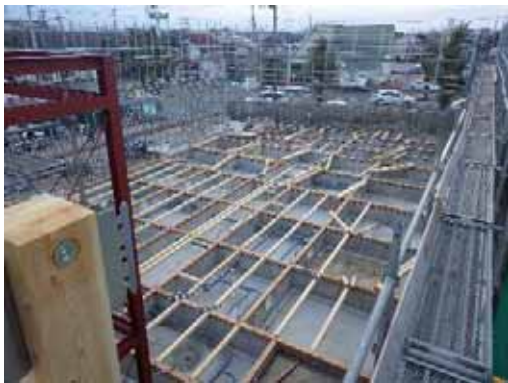
土台・大引き取付 3 日目 (B 工区)
