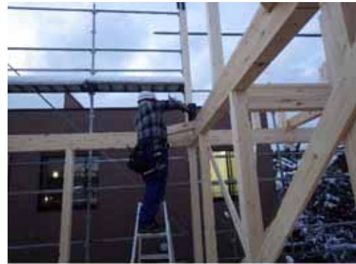
木製火打ち取付
