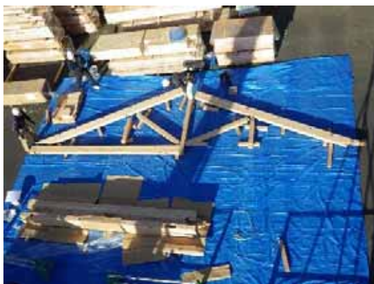
部材組立(部材間配り)
