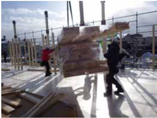
資材搬入_梁(非住 A)
