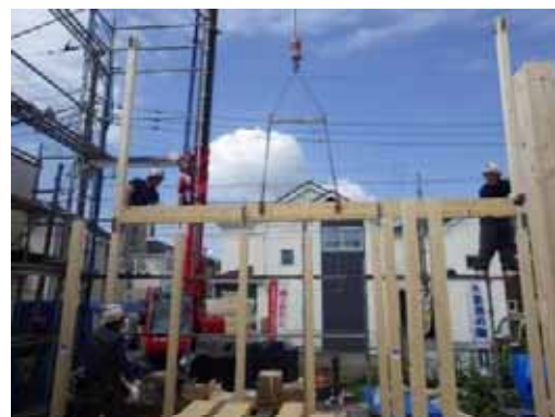
一般梁_2F 床梁 揚重取付(戸建 D)
