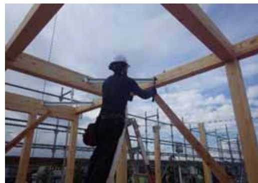
鋼製火打ち取付(非住 F)
