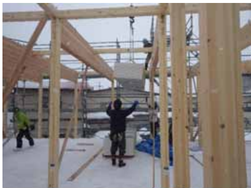
資材搬入_仕上(ボード)(非住 D)
