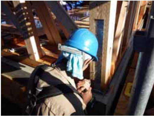
1F 柱脚金物取付_高倍率耐力壁部
