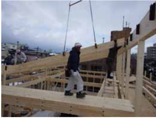
一般梁_勾配梁_揚重取付(非住 A)
