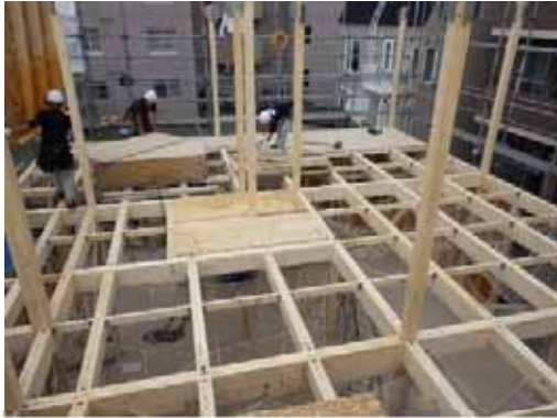
2F 床合板取付
