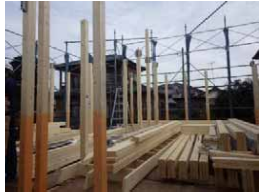
調査前状況_柱取付済み
