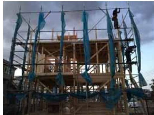
全景_建方完了
