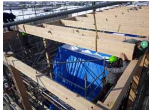
小屋梁(重量梁)揚重取付
