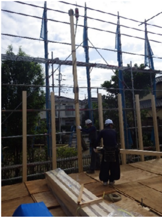
一般柱(通し柱)_揚重取付状況(戸建 D)
