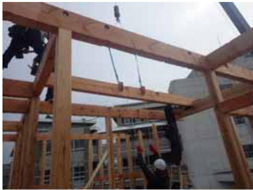
小屋梁_揚重取付
