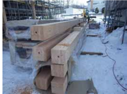
重量柱 資材ヤード平積み
