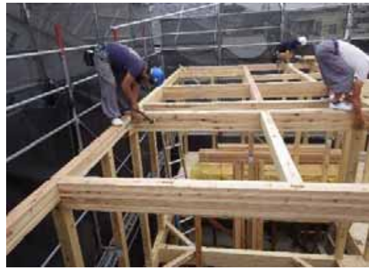
梁接合_継手金物取付
