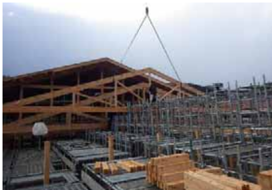
Tトラス 18-L-3 部材設置
