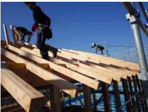
垂木_人力取付
