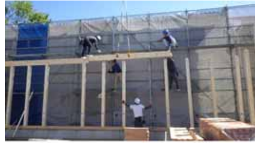
小屋梁_揚重取付
