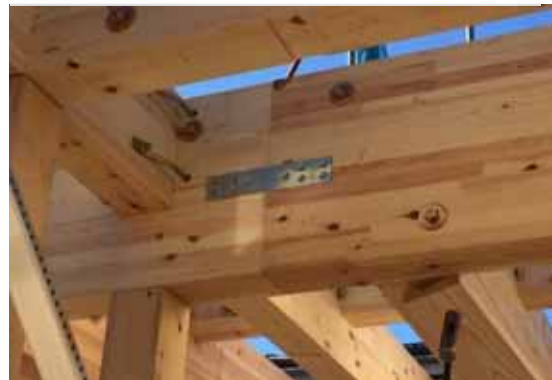
梁継手接合_継手金物
