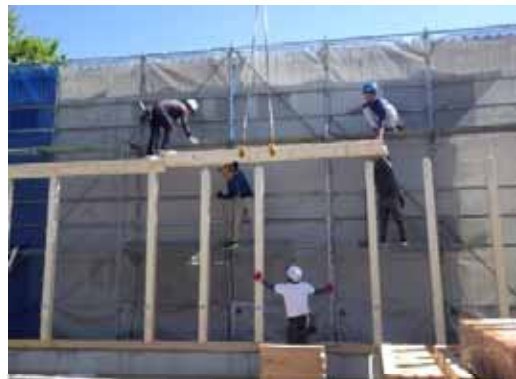
一般梁_小屋梁_揚重取付(非住 M)
