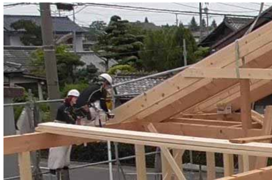
Rトラス 8-P-4 部材設置
