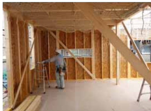
1F 壁パネル設置後の内部状況
