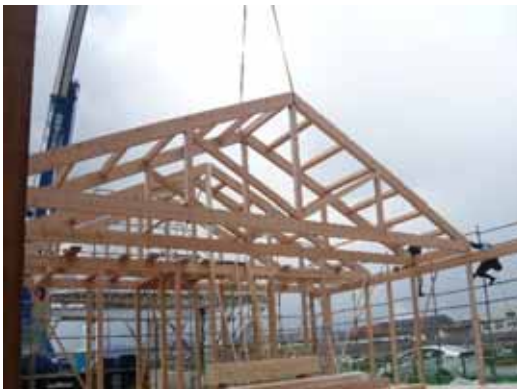
Uトラス 12-N-2 部材設置
