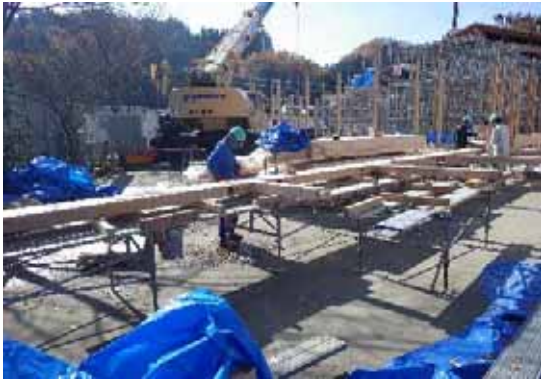
陸梁・束・斜材組立(陸梁・束組立)
