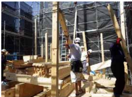
1F 柱_人力取付
