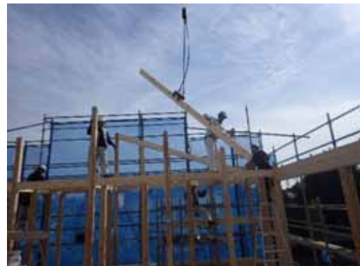
勾配梁 揚重取付
