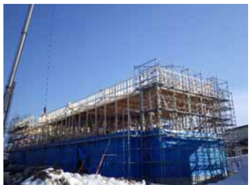
全景_建て方完了
