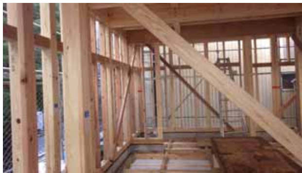
合板受材取付後
