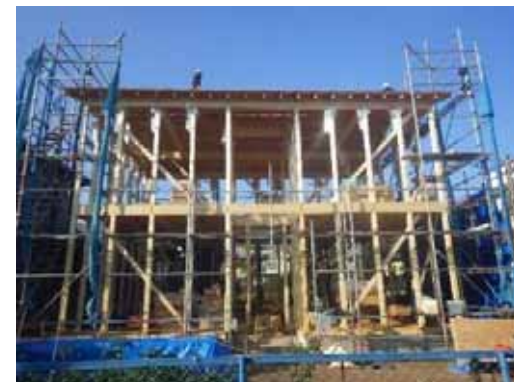
全景_建て方完了
