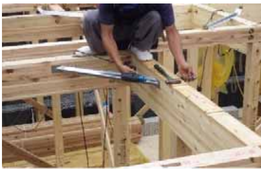
鋼製火打ち取付(戸建 A)
