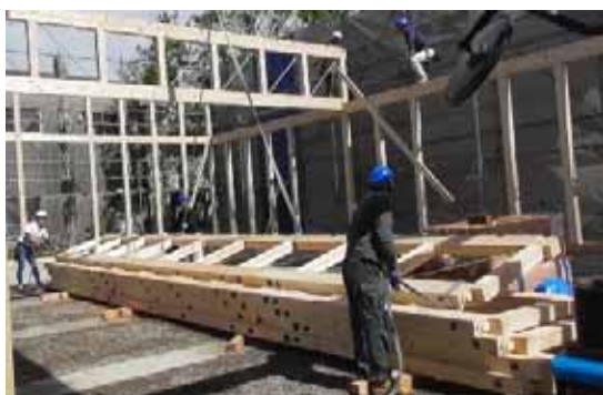
Hトラス 10-M-2 建て起こし
