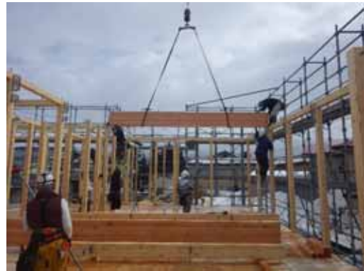
重量梁_揚重取付
