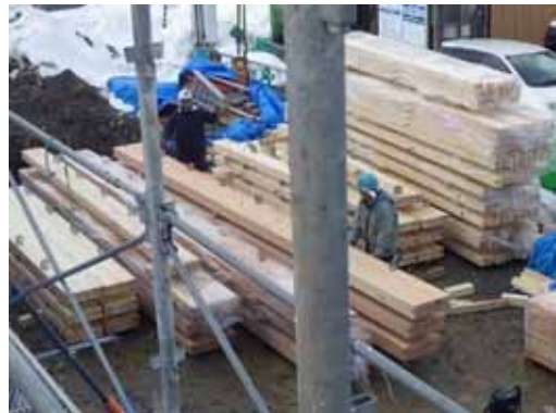
重量梁_小屋梁_地上玉掛け(非住D)
