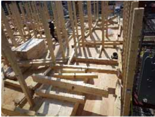
小屋梁の間配り
