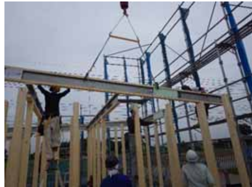
一般梁_2F 床梁_揚重取付(非住 B)
