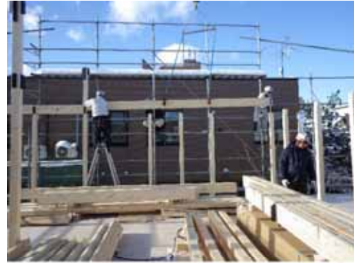
小屋梁_揚重取付
