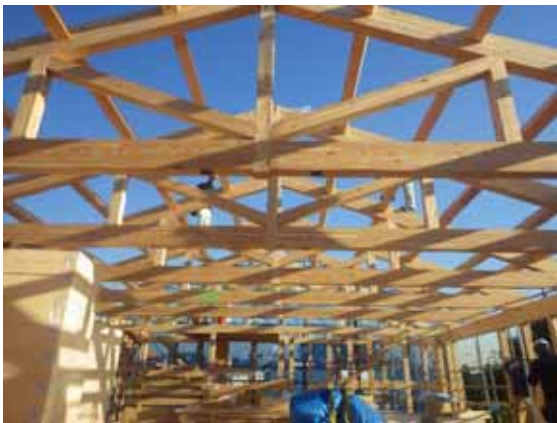
キングポストトラス状況
