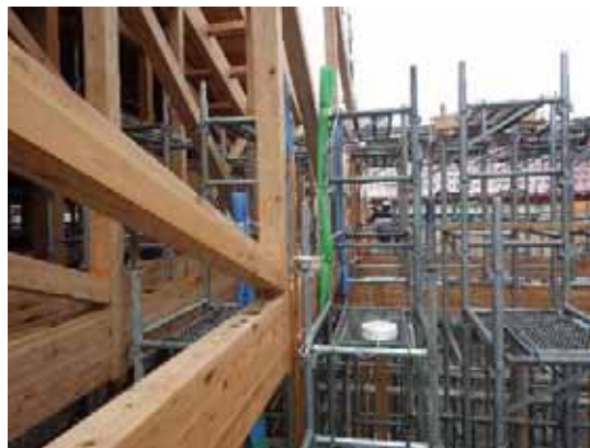
Tトラス 18-L-3 部材設置(足場間に落とし込み)
