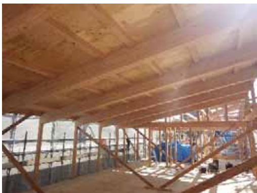
勾配梁_設置後状況
