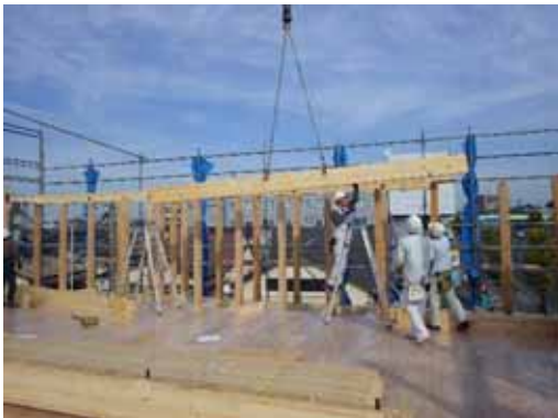
小屋梁 揚重取付
