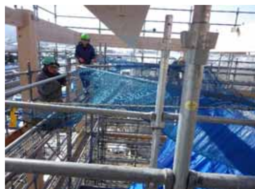
水平ネット設置
