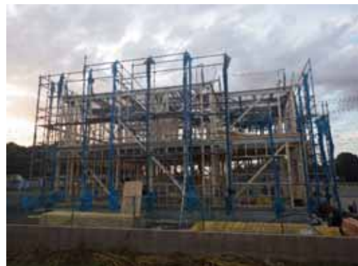
全景_建て方完了
