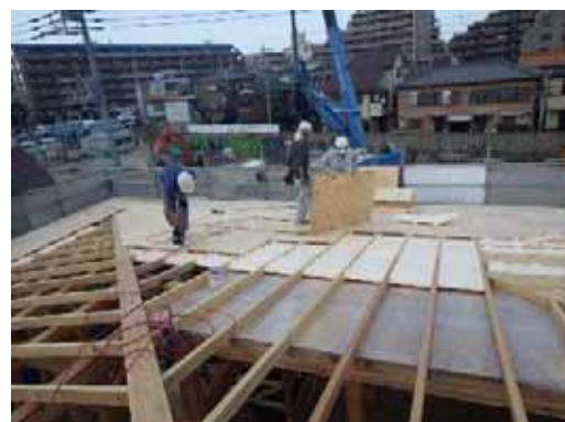
野地合板取付 (2)
