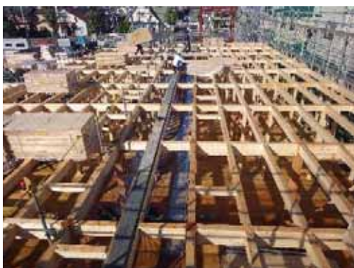
水平ネット・親網設置状況
