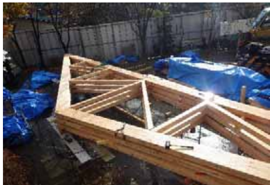
Tトラス全景
