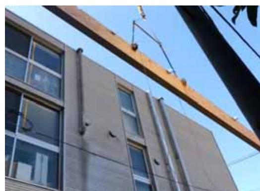
重量梁_大梁_資材ヤードからの揚重(非住H)
