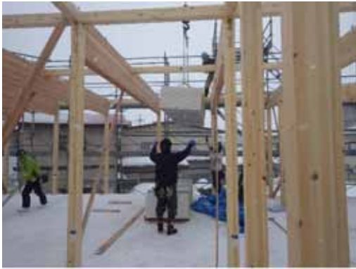
搬入_仕上石膏ボード
