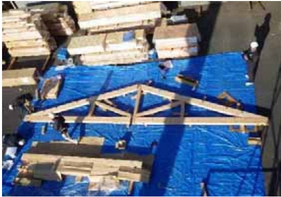
部材組立(嵌合部接合)
