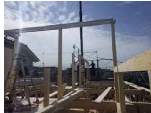
棟木(母屋)_揚重取付
