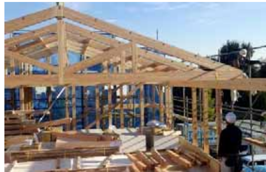
Kトラス 9-K-3 部材設置
