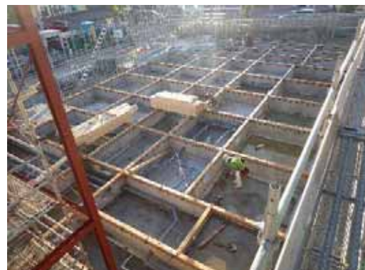
土台_大引き取付 2 日目 (B 工区)
