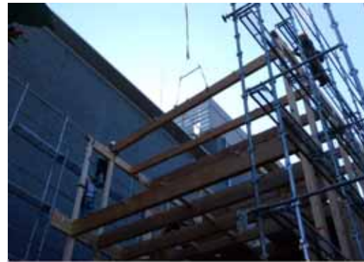
4 工区_小屋梁(重量梁)_揚重取付
