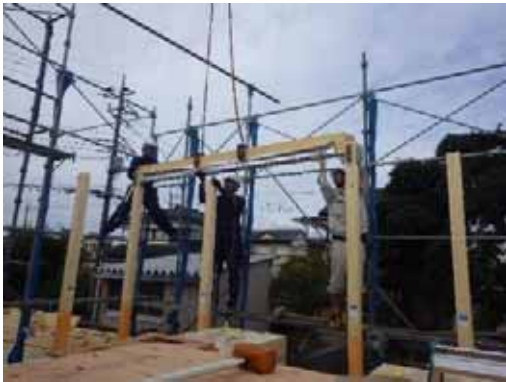
小屋梁_揚重取付
