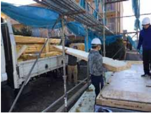
搬入_人力で荷下ろし
