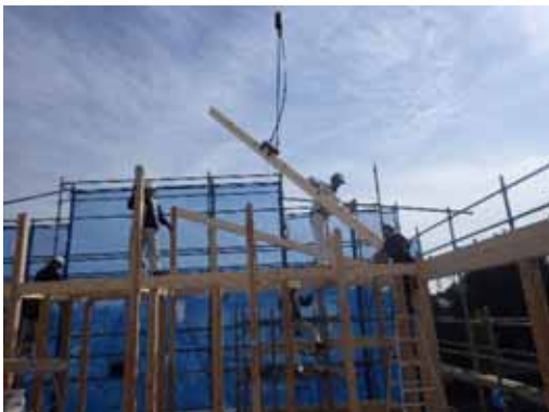
一般梁_勾配梁_揚重取付(非住 K)
