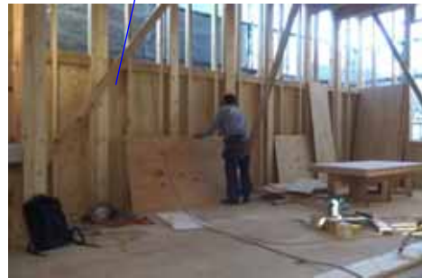
B部面材取付後
