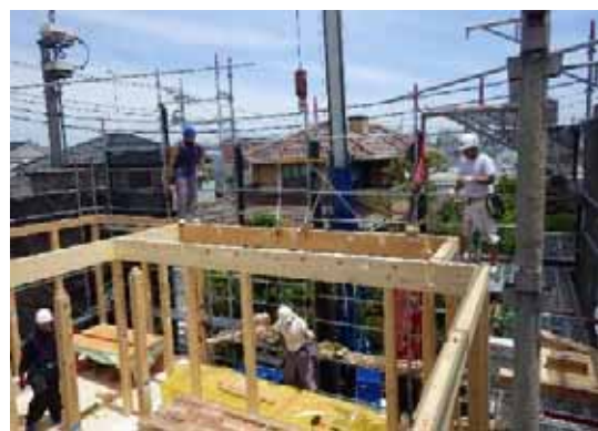
小屋梁_揚重取付
