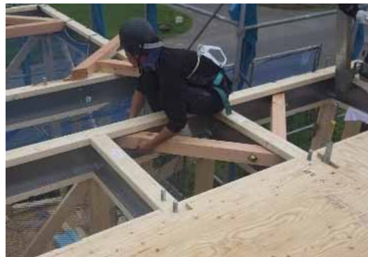
木製火打ち取付(非住 B)
