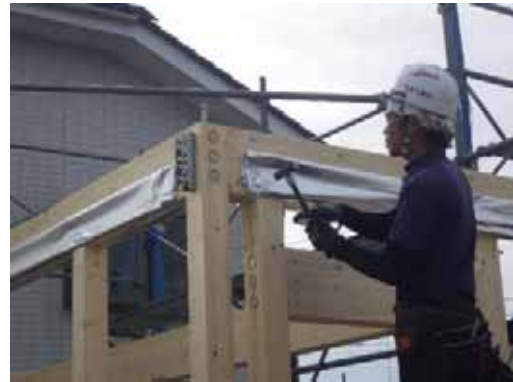
小屋梁接合_ドリフトピン打ち込み
