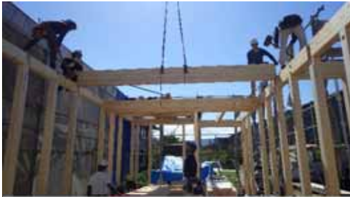
小屋梁_揚重取付
