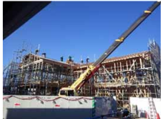
全景_野地合板施工中
