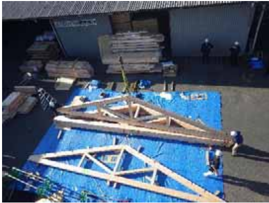
Kトラス 9-K-1 玉掛・建て起こし
