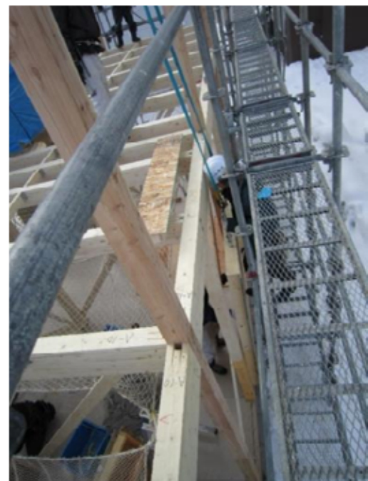
1F 壁パネル_揚重取付 (3)
