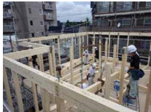
小屋梁_揚重取付
