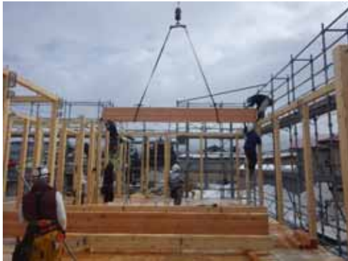
重量梁_小屋梁_揚重取付(非住D)
