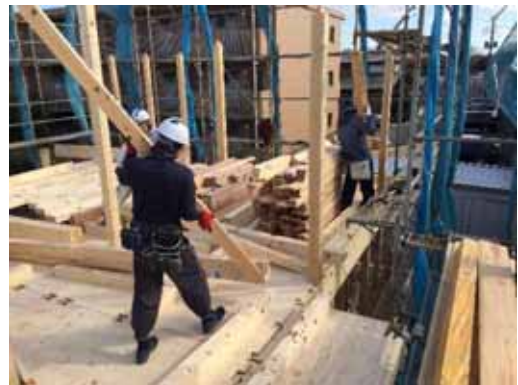
2F 柱_人力取付
