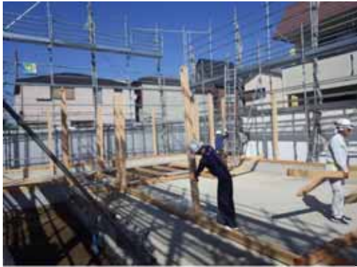
柱_人力取付(非住 E)
