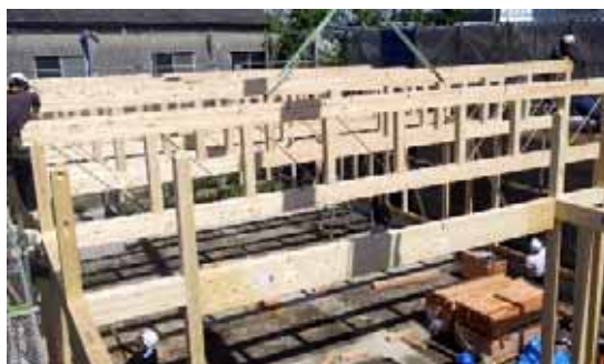
Hトラス 10-M-5 部材取付
