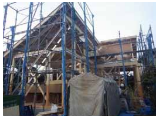
全景_建て方完了
