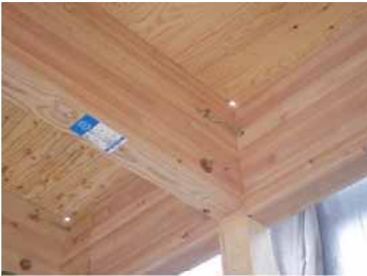
梁端接合部_羽子板ボルト
