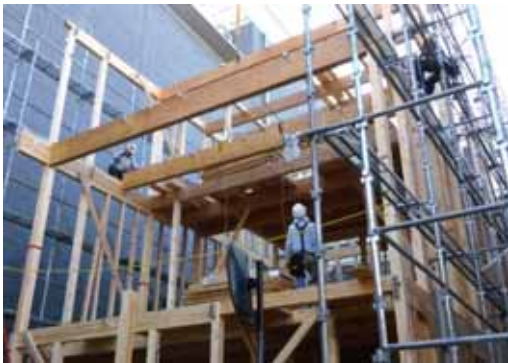
3 工区_3F 床梁(重量梁)_揚重取付
