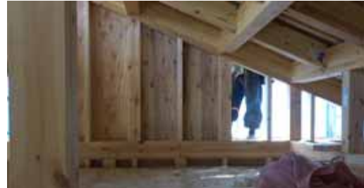
B部_面材取付(斜め壁)(大工B)
