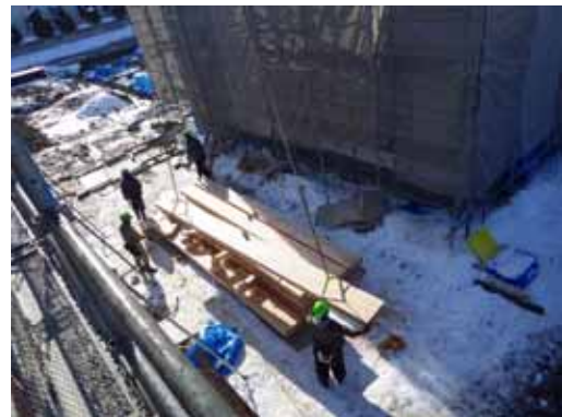
小屋梁(重量梁)建て起こし
