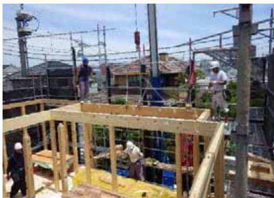
一般梁_小屋梁 揚重取付(戸建 A)
