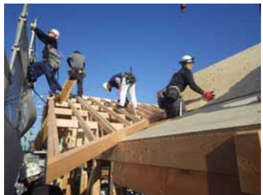
勾配屋根_トラス上24mm厚物合板取付(非住J)
