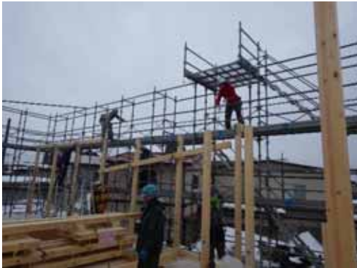
一般梁_小屋梁_人力揚重取付(非住 D)
