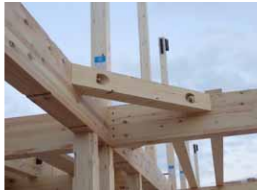
木製火打ち_大入れ + ボルト接合
