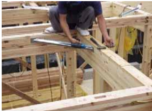
火打ち金物取付
