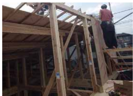
壁面材の先行張付け
