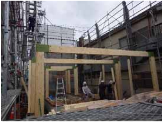
開口フレーム取付状況(調査前日に取付)
