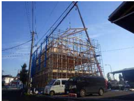
全景_キングポストトラス揚重
