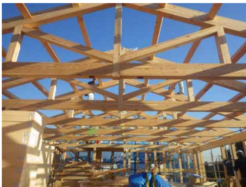
写4-1-1 キングポストトラス全景(非住K)
