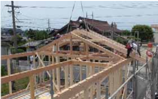
Rトラス 8-P-2 部材設置
