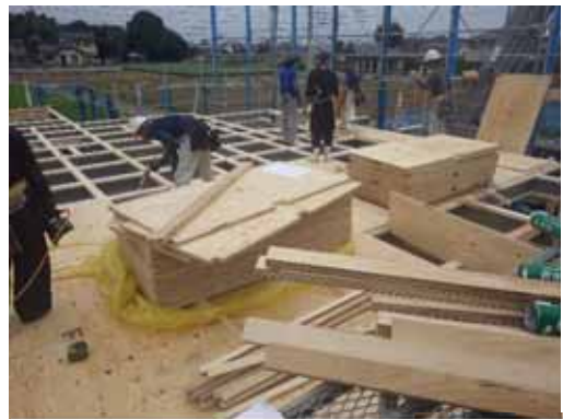
2F 床合板取付
