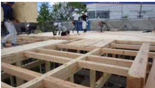
小屋合板取付
