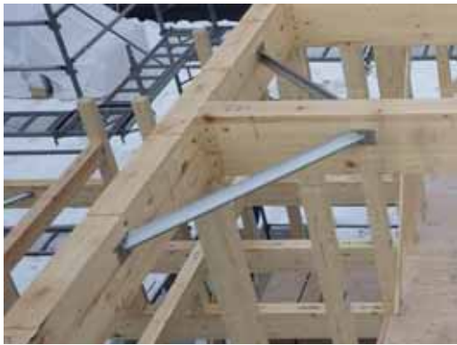
鋼製火打ち_ビス接合
