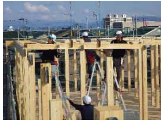
小屋梁_揚重取付
