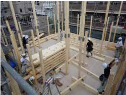
1F 柱取付完了・梁間配り
