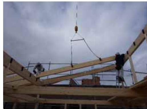
勾配梁_揚重取付
