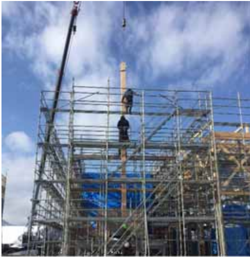
重量柱 揚重取付
