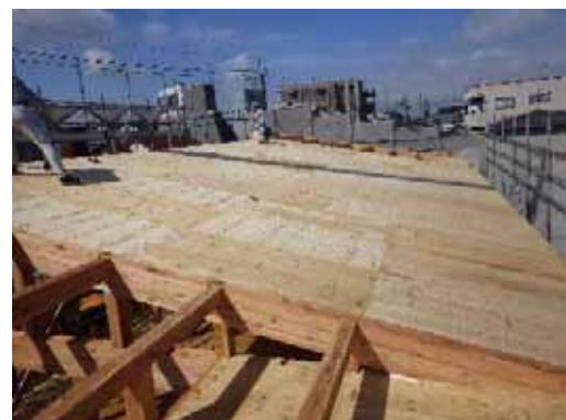
勾配梁上の圧物合板
