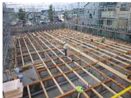
土台・大引き取付 4 日目 (B 工区)
