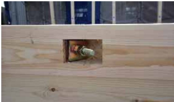
斜材ボルト定着部(座彫り部)
