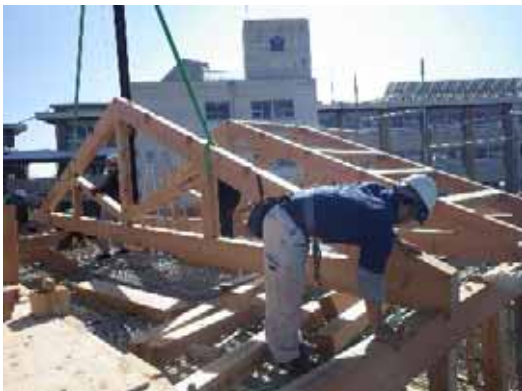
Kトラス 8-J-3 部材設置
