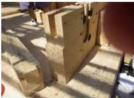
在来工法の梁端仕口
