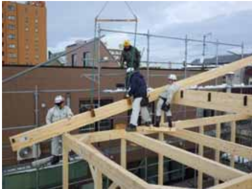
勾配梁(2)_揚重取付
