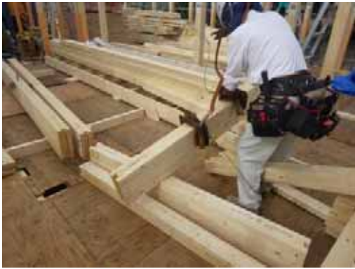
小屋梁_玉掛け
