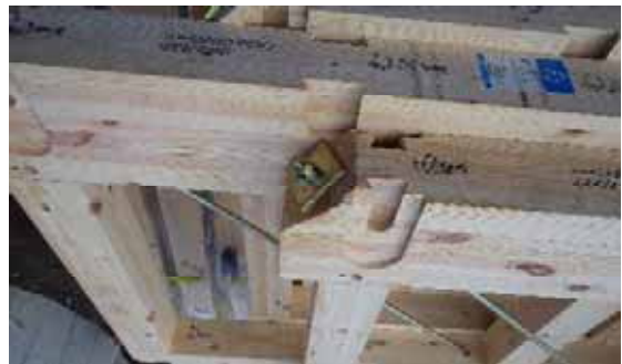
斜材ボルト定着部(上限材端部)
