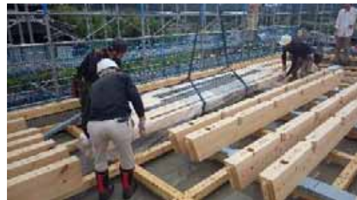
搬入_トラス部材
