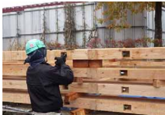
ボルト本締め(引きボルト接合部)
