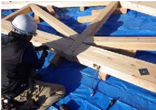
ボルト本締め(引きボルト部)
