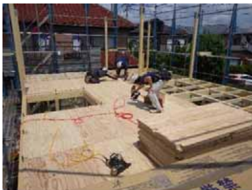
2F 床合板取付
