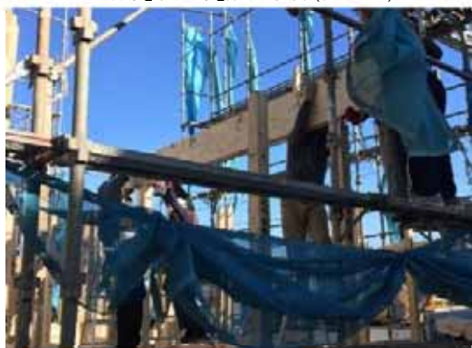
一般梁_2F 床梁_人力揚重取付(戸建 C)
