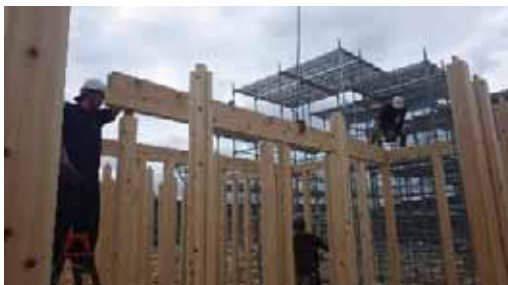
小屋梁_揚重取付
