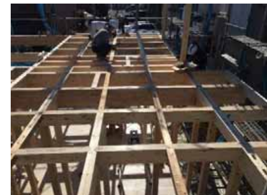
2F 床受_人力取付
