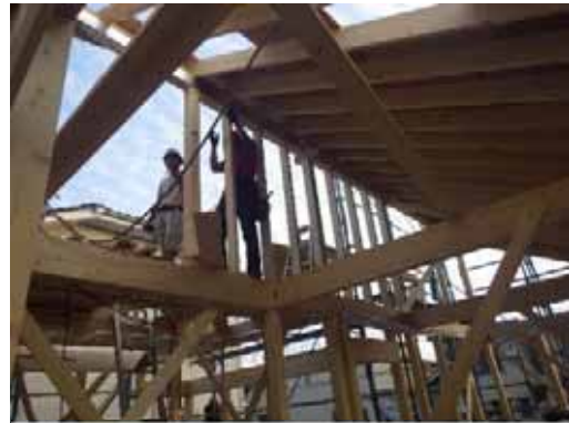
小屋面_間柱取付
