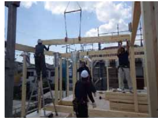
小屋梁_揚重取付
