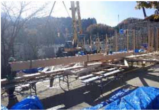
登り梁組立(登り梁継手、揚重機利用)
