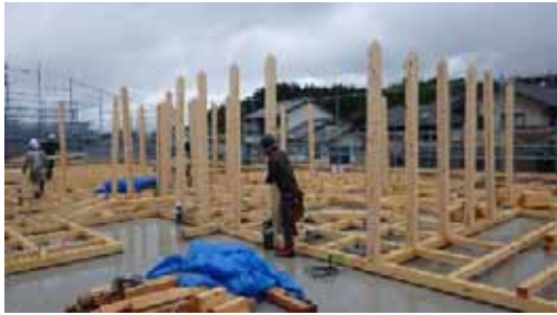
1F 柱_人力取付
