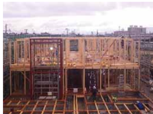
A 工区全景_小屋梁ドリフトピン
