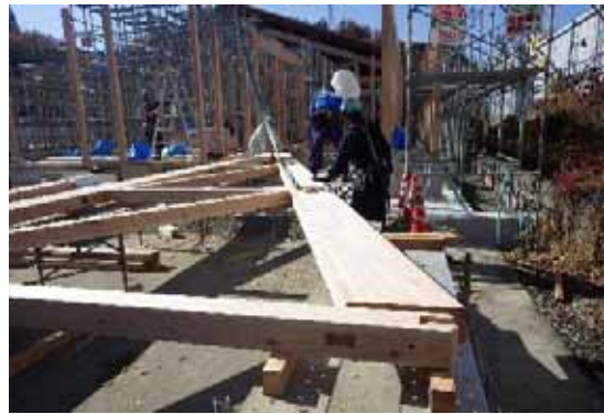
登り梁組立(登り梁叩き込み、揚重機利用)
