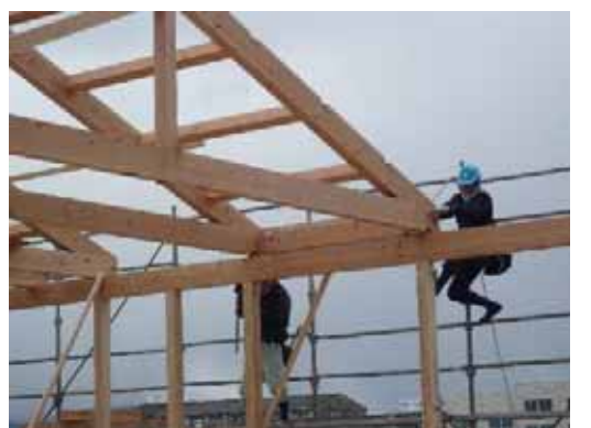
Uトラス 12-N-2 部材設置
