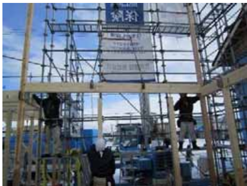
一般梁_2F 床梁 揚重取付(戸建 F)
