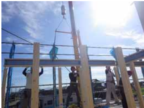
小屋梁 揚重設置
