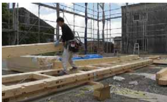
下弦材組立(下弦材間配り)
