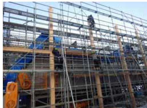
胴差 揚重取付
