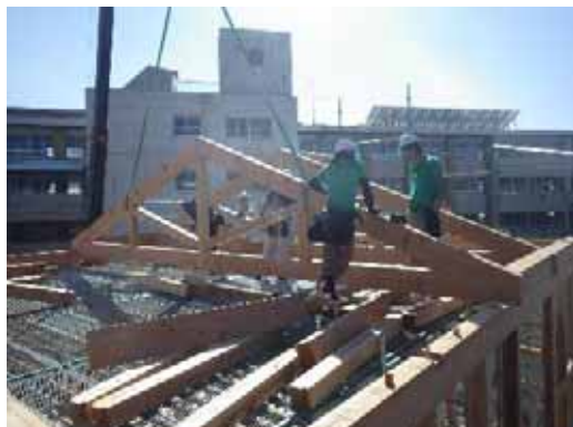
Kトラス 8-J-2 部材設置
