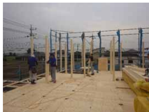
柱_人力取付(非住 B)
