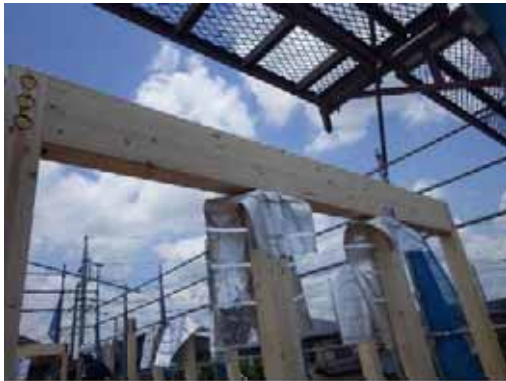
柱頭部_断熱用の気密シート
