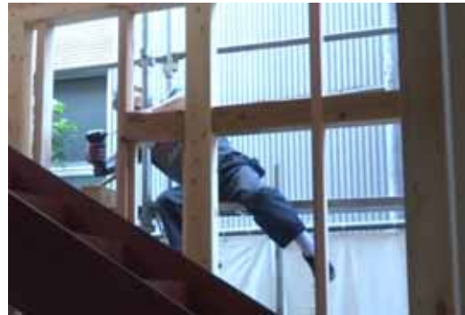
合板受材取付(大工 B)
