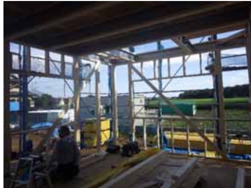
1F 窓枠取付
