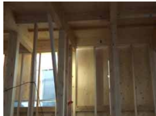
C 部面材取付中
