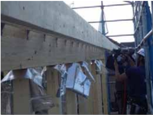
破風板取付(戸建 D)
