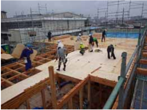
2F 床合板取付
