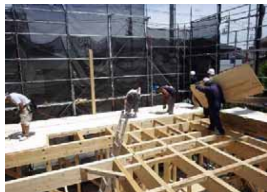
2F 床合板取付
