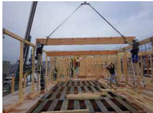
重量梁_小屋梁_揚重取付(非住D)
