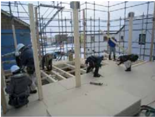
2F 床合板・柱取付
