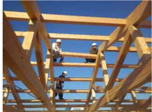
トラス母屋取付
