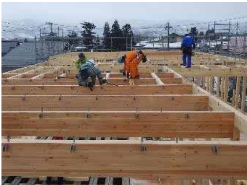
小梁_人力取付
