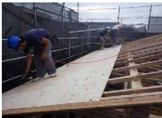
屋根合板取付
