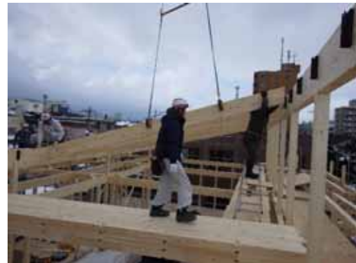
勾配梁(3)_揚重取付
