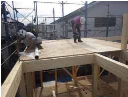
ロフト_床合板取付
