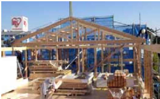
Kトラス 9-K-1 部材設置
