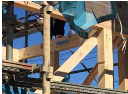
梁接合_継手金物取付
