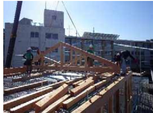
Kトラス 8-J-1 部材設置
