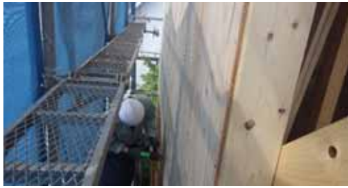
A部_面材取付(大工B)
