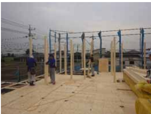
2F 柱_人力取付
