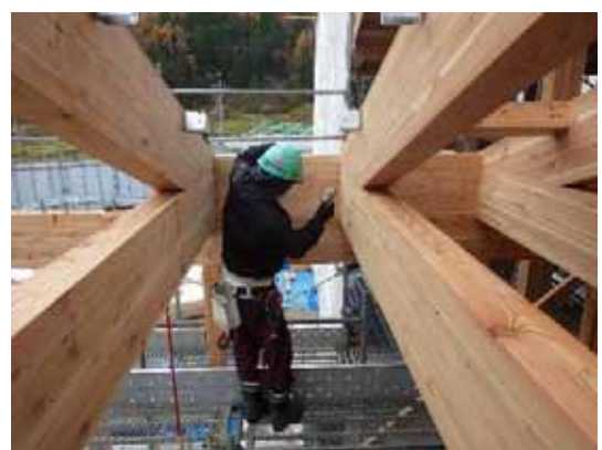
Tトラス 18-L-3 倒れ止め
