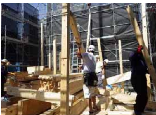
柱_人力取付(戸建 A)
