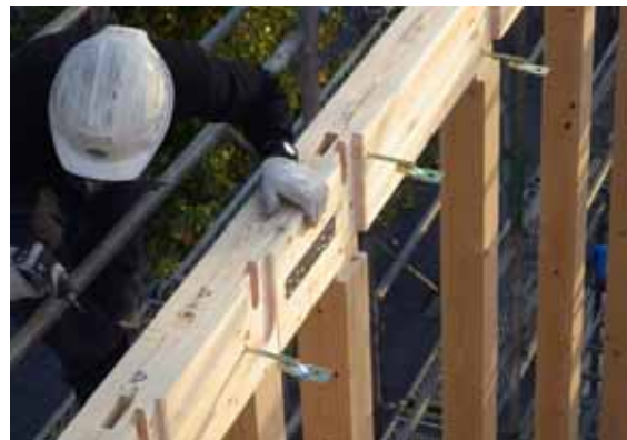
梁継手接合_継手金物取付(非住 K)
