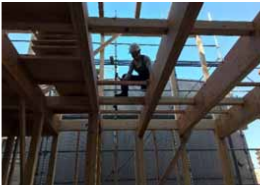
小梁_人力取付
