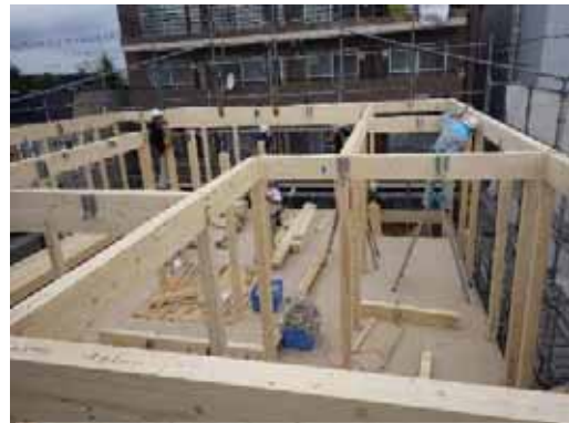
小屋梁_揚重取付 (2)
