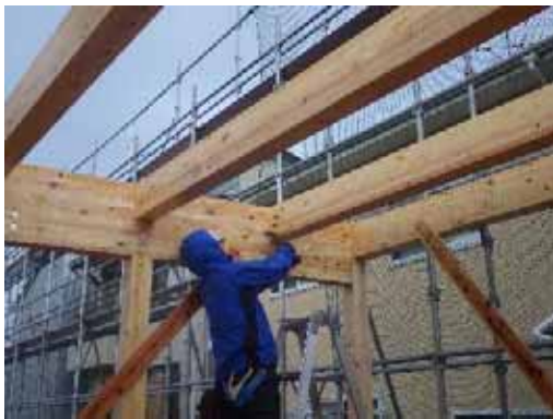
2F 床梁ドリフトピン打ち込み
