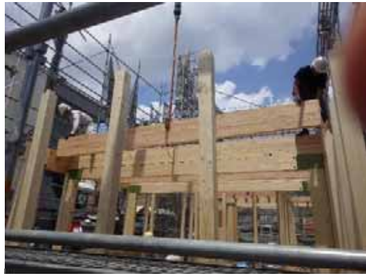
2F 床梁 揚重取付(2)
