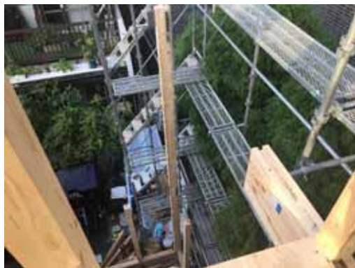
通し柱_設置後
