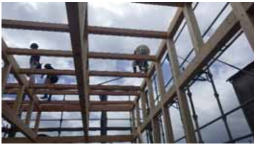
母屋_人力取付
