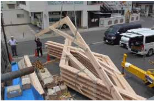
Rトラス 8-P-2 建て起こし
