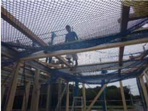
水平ネット設置状況
