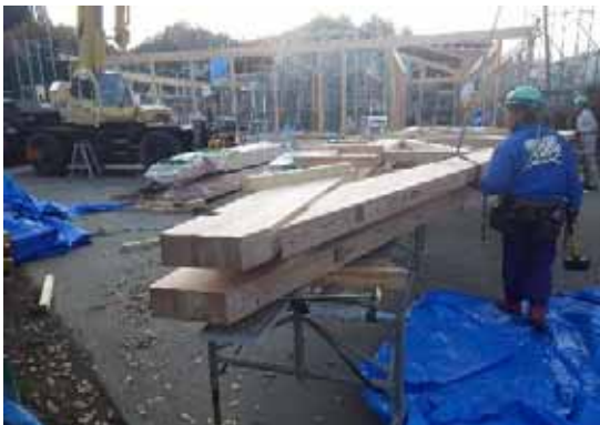
登り梁組立(登り梁叩き込み、揚重機利用)
