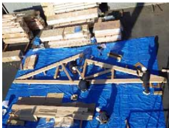
部材組立(嵌合部接合)
