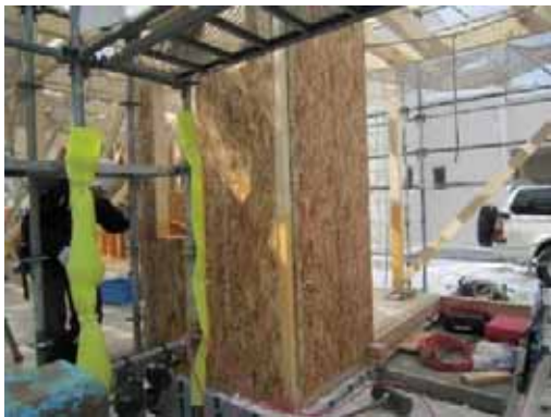
1F 壁パネル_仮止め後
