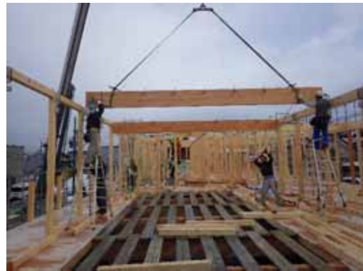
重量梁_揚重取付 (2)
