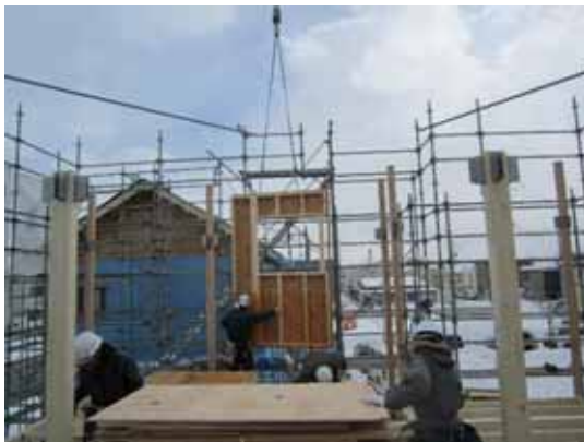
戸建 F_壁パネルの揚重取付
