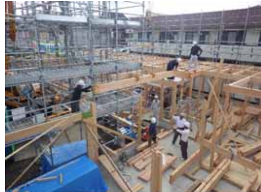
一般梁_2F 床梁_揚重取付(非住 E)
