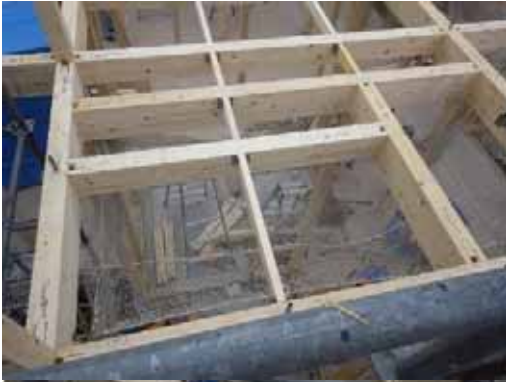
水平ネット取付
