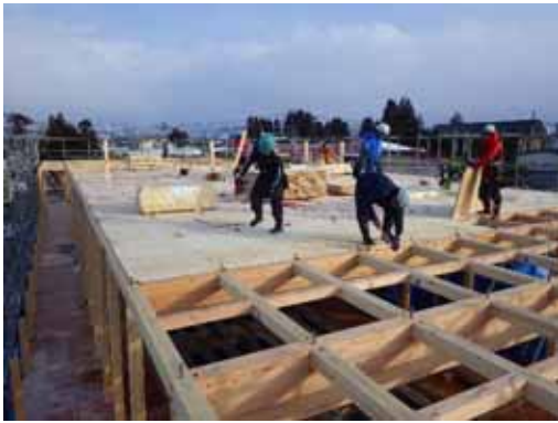
小屋合板取付
