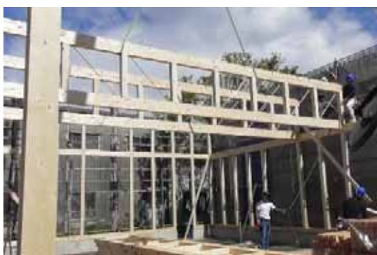
Hトラス 10-M-2 部材設置
