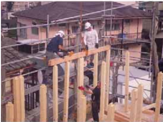
小屋梁_揚重取付
