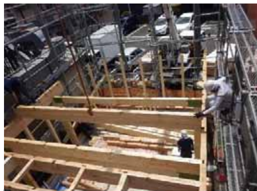
一般梁_2F 床梁 揚重取付(戸建 B)
