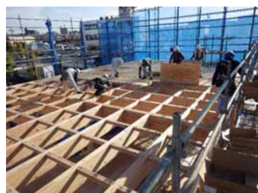
3F 床合板取付
