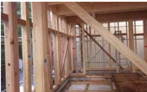
合板受材取付後
