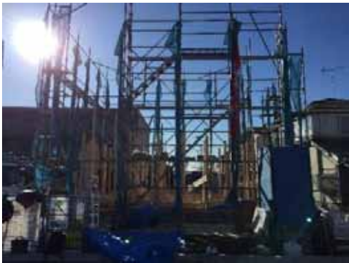
全景_1F 柱完了
