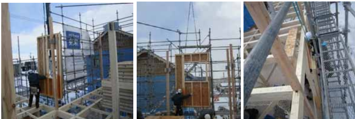
写 3-4-6 壁パネルの揚重取付状況
