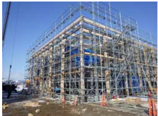
全景_小屋梁設置完了
