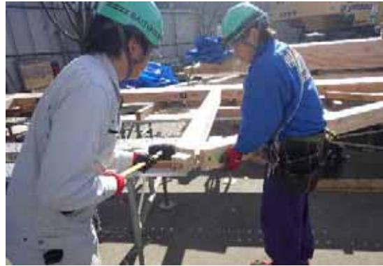
陸梁・束・斜材組立(束・斜材組立)
