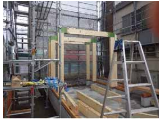
開口フレーム取付状況(2)(調査前日に取付)
