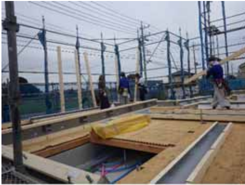
1F 柱_人力取付
