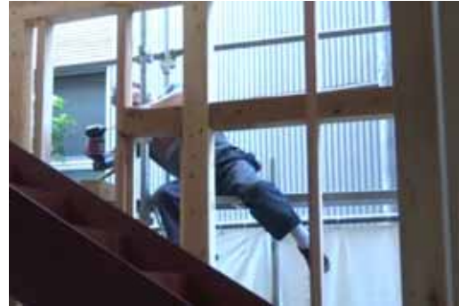
合板受材取付(大工 B)
