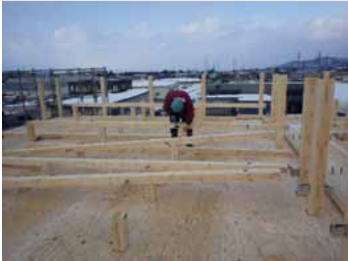
母屋_人力取付
