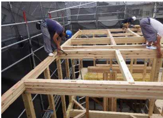
梁端接合_羽子板ボルト取付(戸建 A)
