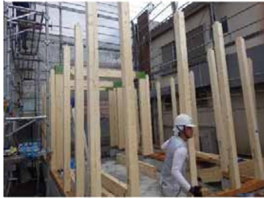
1F 柱 人力取付
