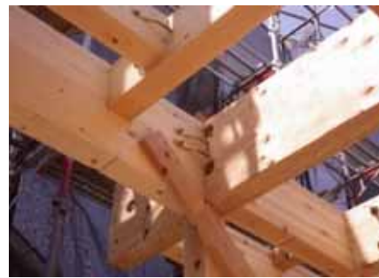
在来工法の梁端接合部
