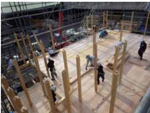
3F 柱_人力取付
