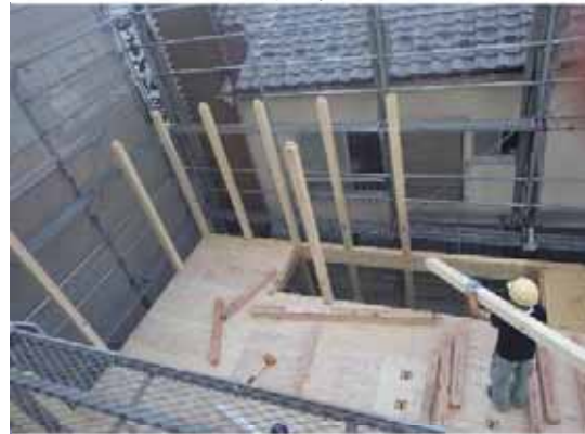
2F 柱_人力取付
