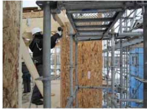
壁合板釘打ち
