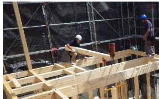
写 3-2-2 小梁の人力取付
