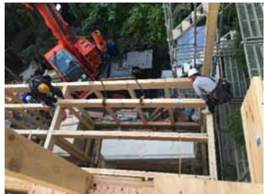
5 工区_2F 床梁_揚重取付
