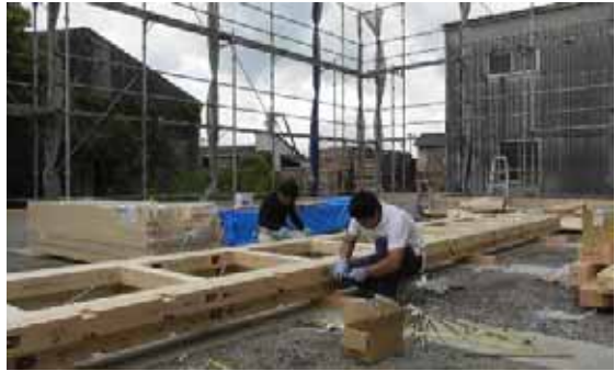
斜材ボルト本締め
