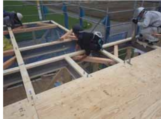
2F 木製火打ち取付
