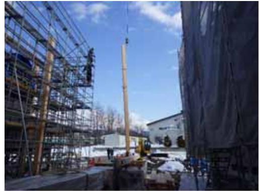
重量柱 玉掛け
