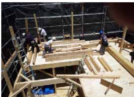
2F 柱_人力取付
