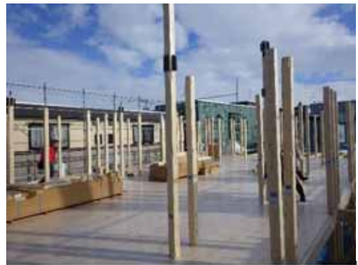
2F 柱_人力取付
