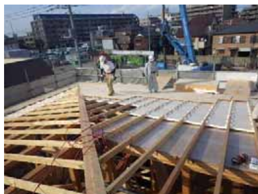
野地合板取付
