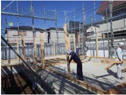
1F 柱_人力取付
