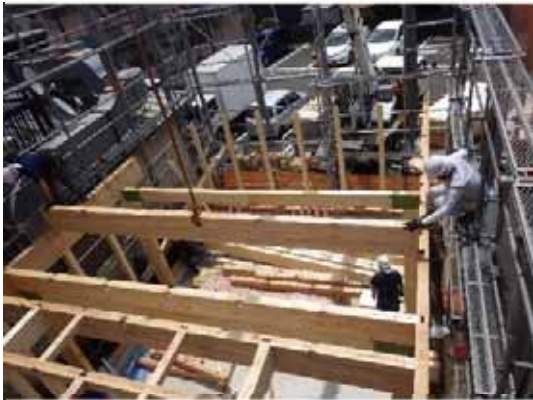
2F 床梁 揚重取付
