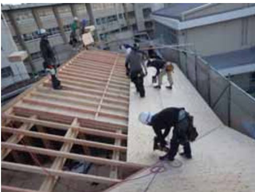
野地合板取付
