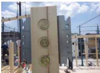
金物工法の梁端仕口
