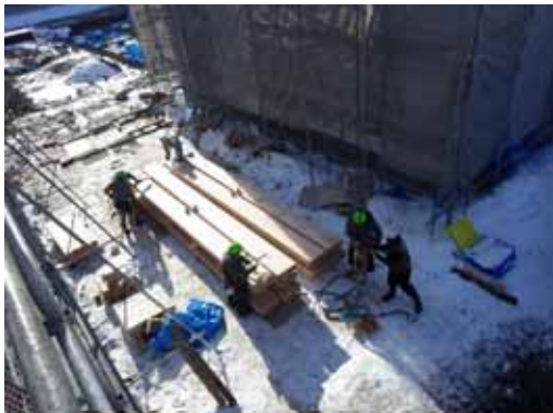
重量梁_小屋梁_資材ヤード平積み(非住C)
