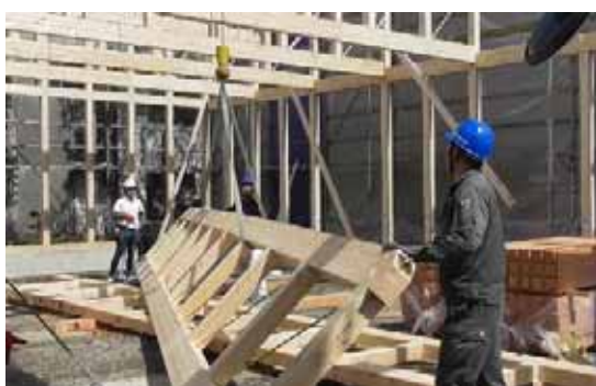
Hトラス 10-M-5 建て起こし
