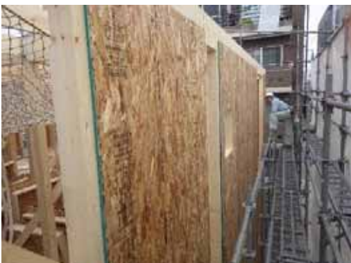
1F 壁パネル設置後の外部状況
