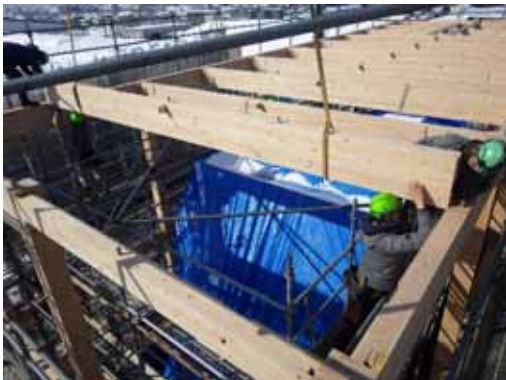
重量梁_小屋梁_揚重取付(非住C)
