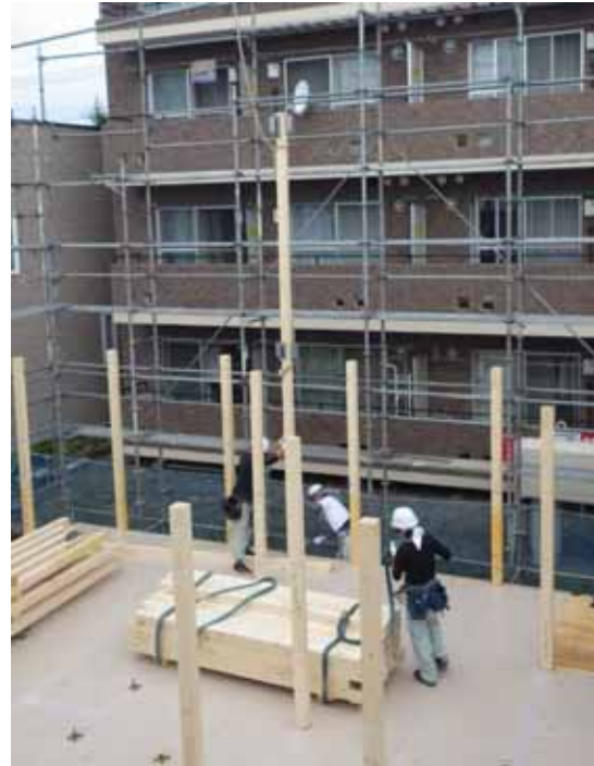
一般柱(通し柱)_揚重取付状況(戸建 G)
