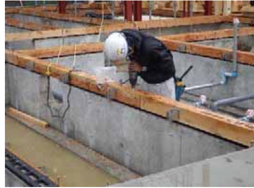
土台取付(B工区)
