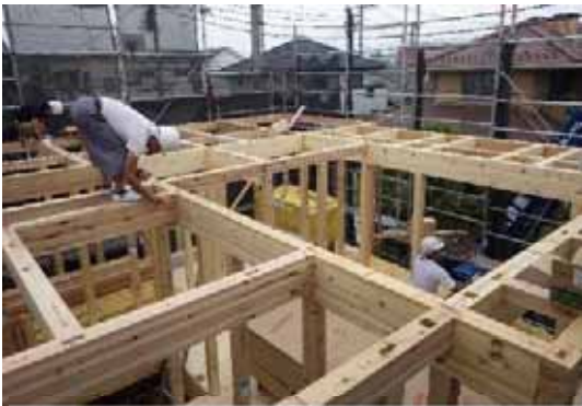
梁端接合_羽子板ボルト取付(戸建 A)
