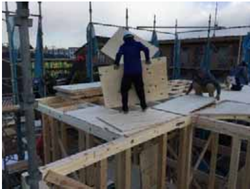
小屋水平構面合板取付
