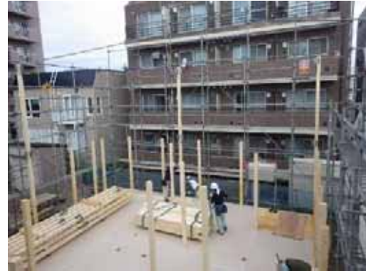
通し柱_揚重取付
