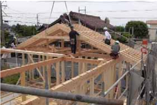
Rトラス 8-P-4 部材設置
