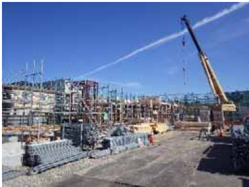
全景_A 工区 1F 立上り
