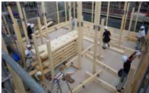
写 3-2-1 梁の間配り状況
