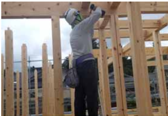
梁端接合_羽子板ボルト取付(非住 G)
