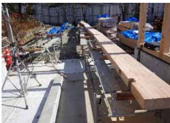
陸梁・束・斜材組立(部材間配り、揚重機利用)
