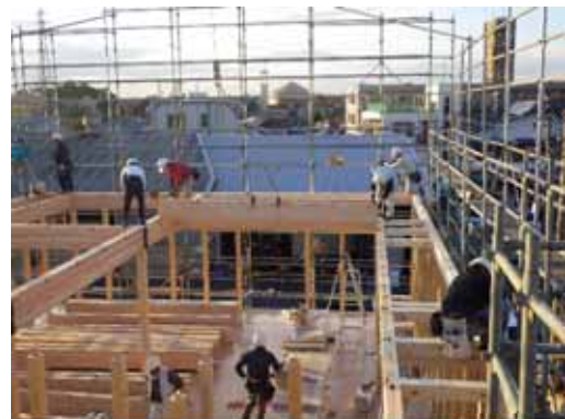
一般梁_3F 床梁_揚重取付(非住 K)
