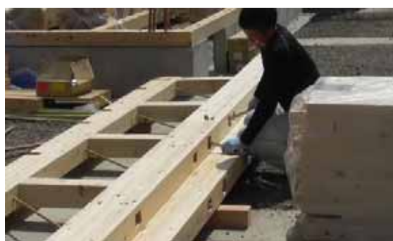
継手ボルト本締め(下弦材継手)
