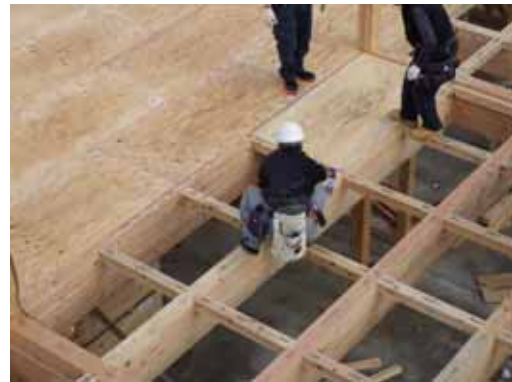
2F 床合板取付_接着剤利用
