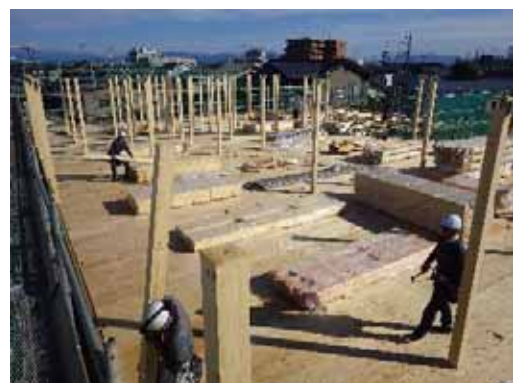
2F 柱_人力取付
