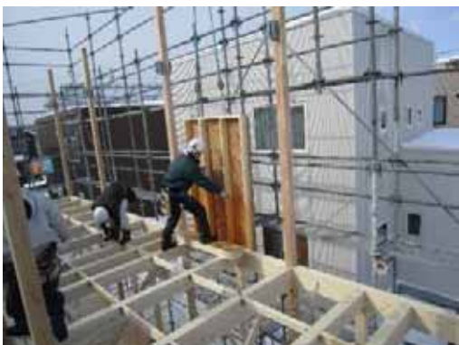
1F 壁パネル_揚重取付 (2)
