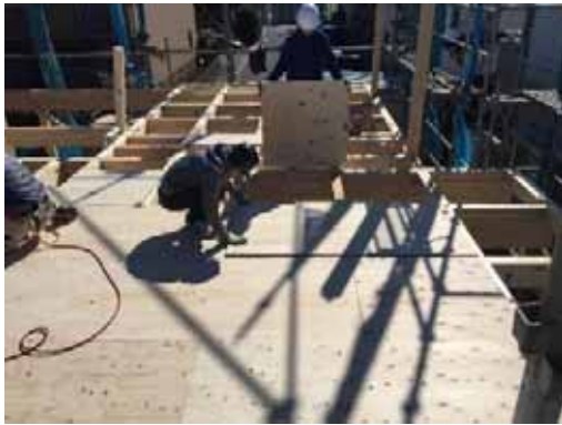
2F 床合板取付
