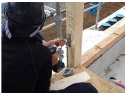
柱接合_HD 金物取付
