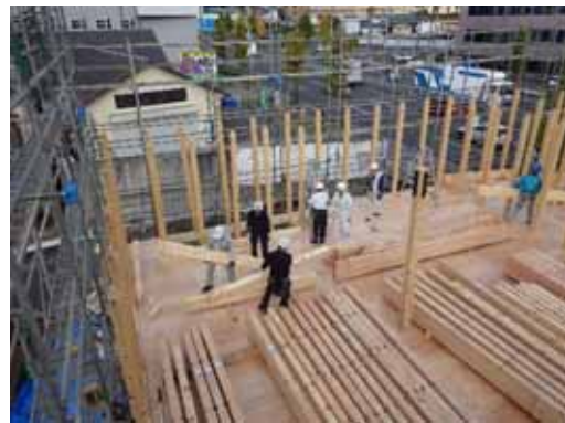
3F 床梁間配り
