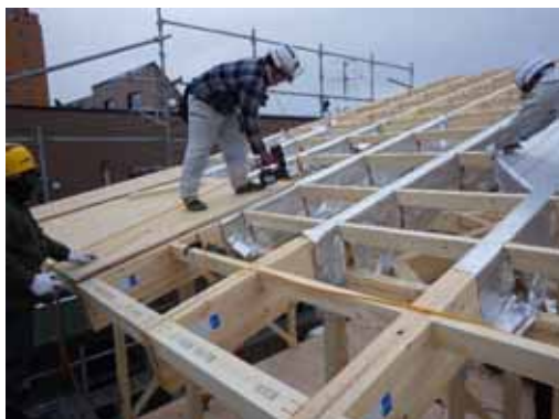
屋根合板取付
