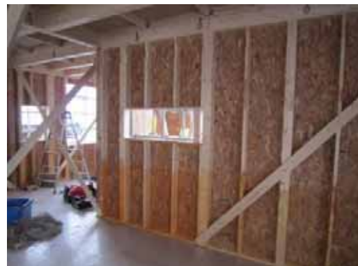
1F 壁パネル取付後
