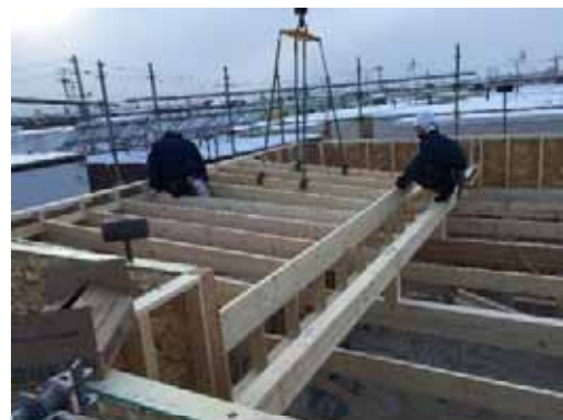
垂木ユニット_揚重取付
