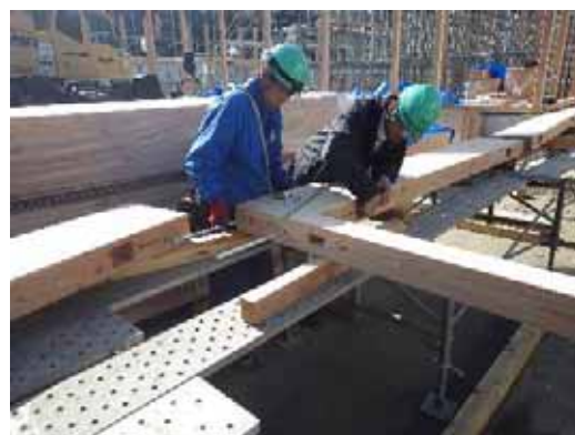
陸梁・束・斜材組立(陸梁・束組立)
