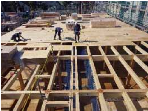
2F 床合板取付
