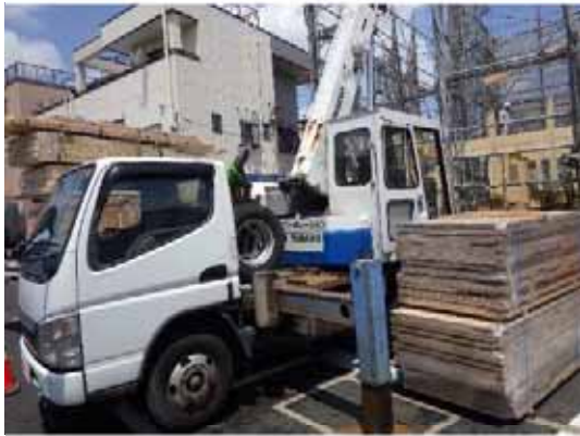
揚重機設置状況
