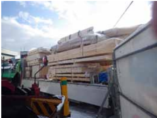
搬入_小屋梁他
