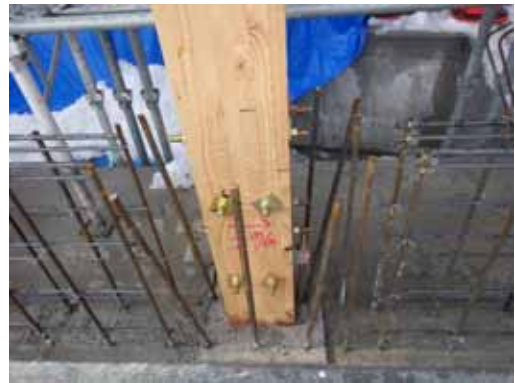
重量柱 柱脚部設置後
