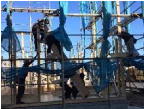
2F 床梁_人力揚重取付
