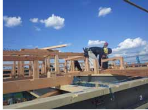
RF 母屋・束 人力取付
