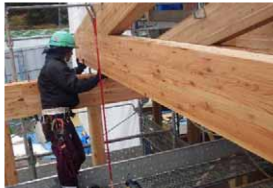
Tトラス 18-L-3 部材設置
