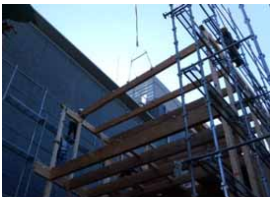
重量梁_大梁_揚重取付(非住H)
