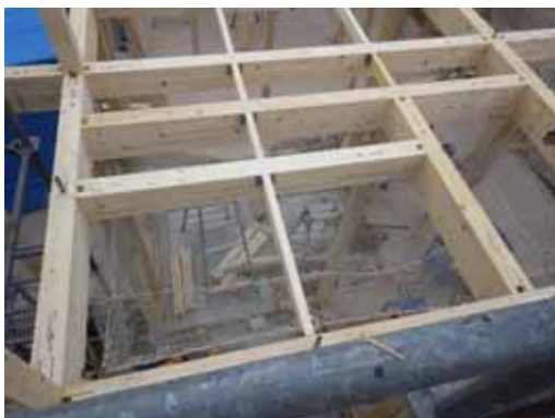
水平ネット取付
