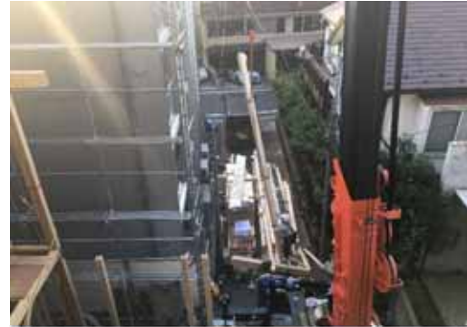
通し柱_建て起こし
