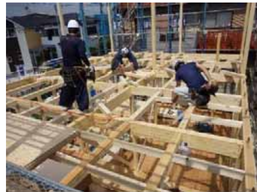
2F 床受_間配り・人力取付
