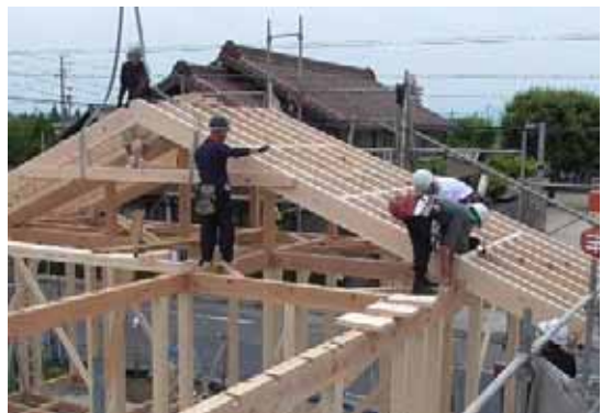
Rトラス 8-P-5 部材設置
