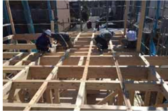
梁端接合_羽子板ボルト取付(戸建 C)
