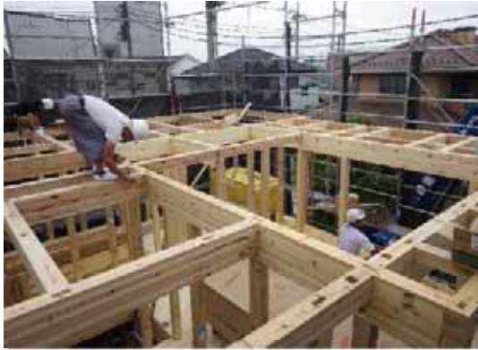
梁接合_羽子板ボルト取付
