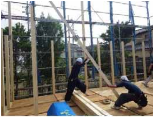
通し柱_人力取付
