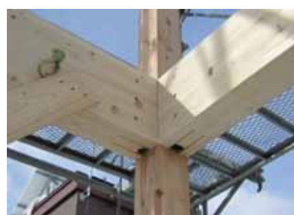
金物工法の梁端接合部
