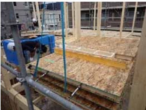
壁パネル_玉掛け
