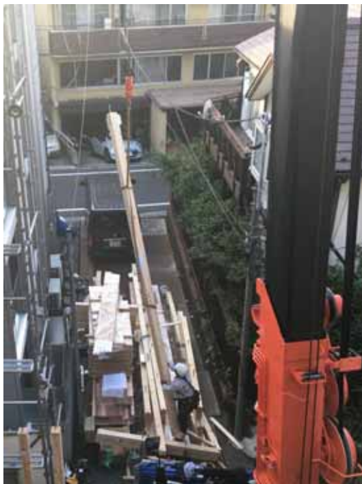
一般柱(通し柱)_揚重取付状況(非住 H)
