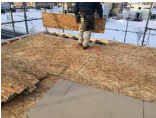
野地合板取付
