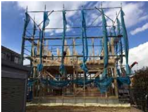
全景_2F 柱完了
