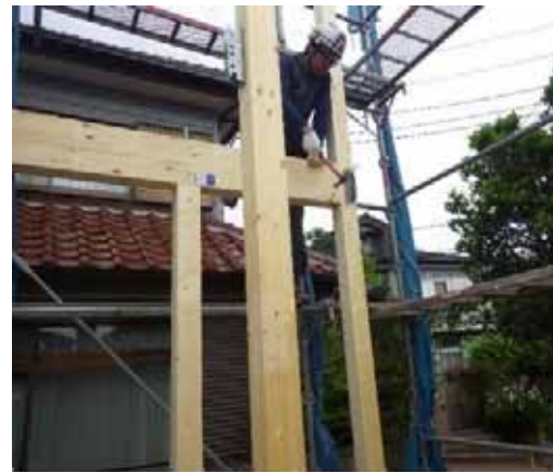
梁接合_ドリフトピン打ち込み
