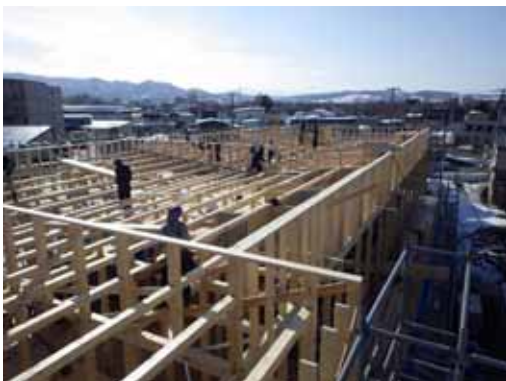
屋根下地工事_母屋・垂木
