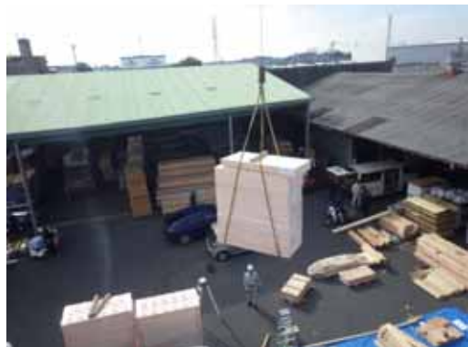
資材搬入_仕上(断熱材)(非住 K)
