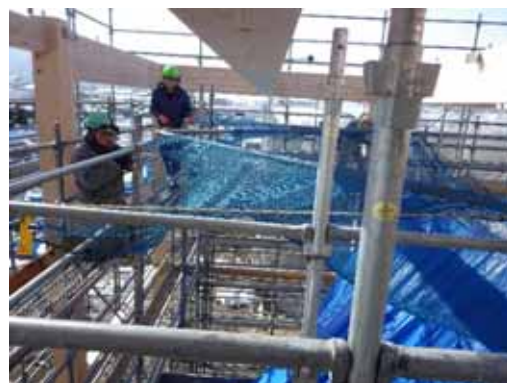
水平ネット取付(2)
