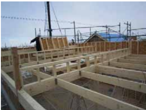
パラペット立上り束ユニット_揚重取付
