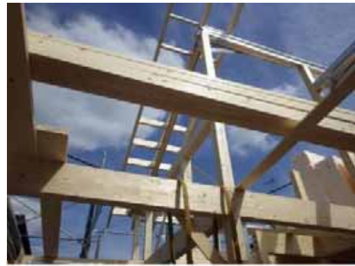
垂木ユニット_取付後
