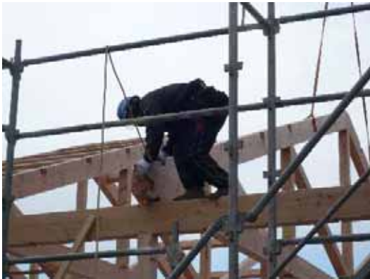
Kトラス 12-N-1 部材設置
