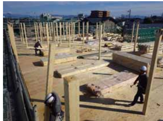
非住 F_柱取付 (人力作業主体で揚重機非稼働)
