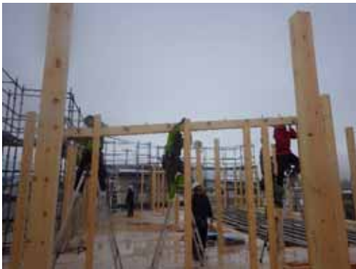
小屋梁_人力揚重 (2)
