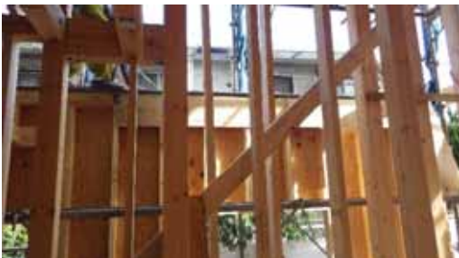
D部_面材取付(大工C)
