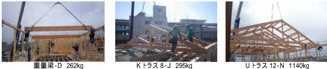
写 4-3-7 重量梁とトラスの部材重量
