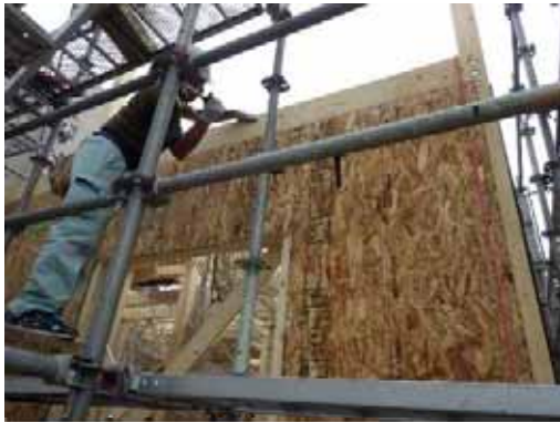
壁合板釘打ち
