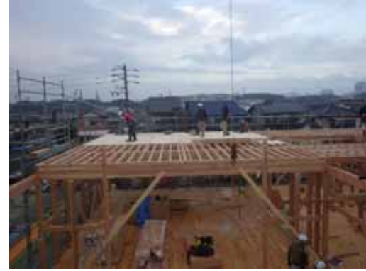
小屋合板取付
