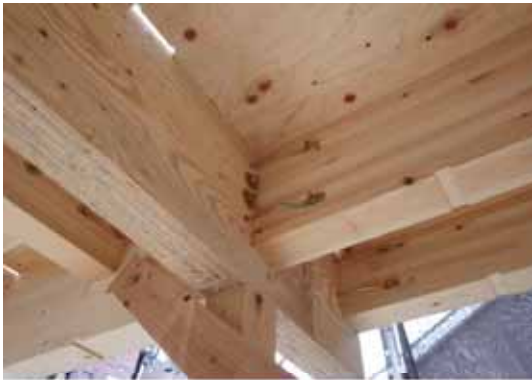
梁端接合_羽子板ボルト
