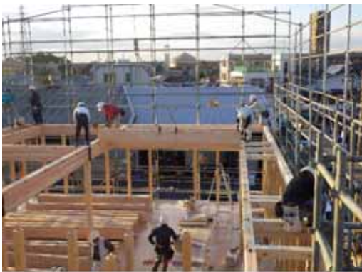
3F 床梁_揚重取付
