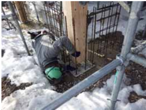
重量柱 柱脚部
