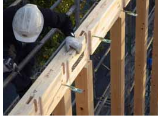
継手接合金物取付
