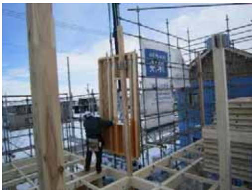
1F 壁パネル_揚重取付
