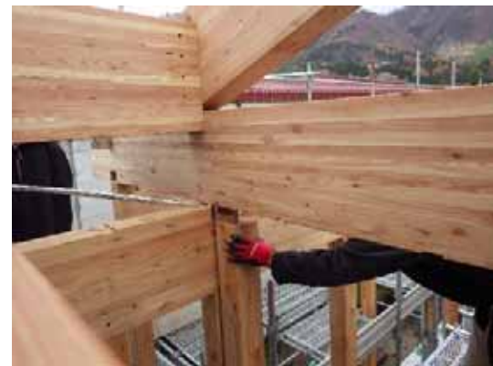
Tトラス 18-L-3 部材設置(複数接合部に設置)
