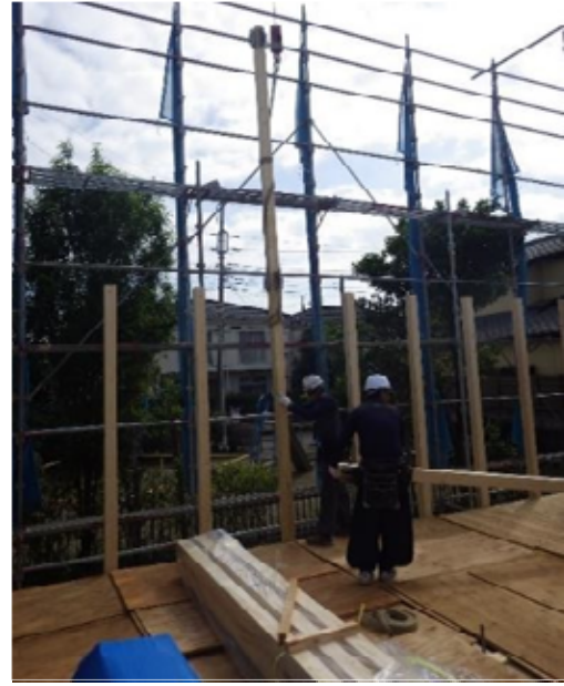
通し柱_揚重取付
