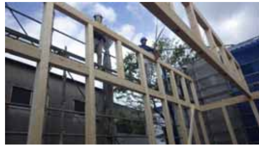
トラス繋ぎ梁_揚重取付
