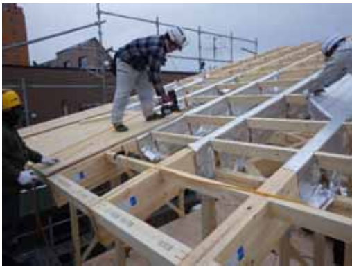
勾配屋根_24mm厚物合板取付(非住A)
