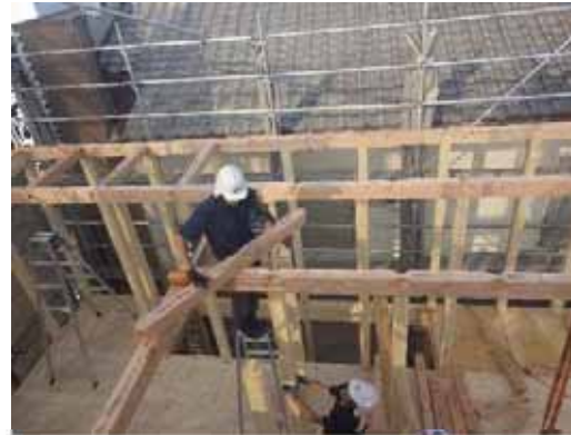
小梁_人力取付(戸建 B)
