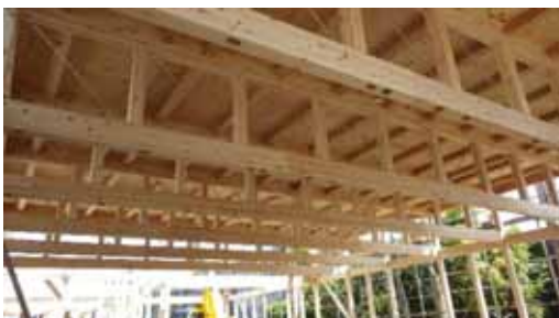
小屋合板貼付後のトラス状況
