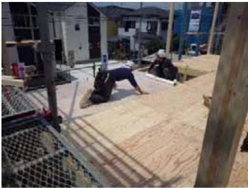
2F 床養生シート貼り
