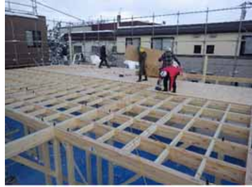
2F 床合板取付
