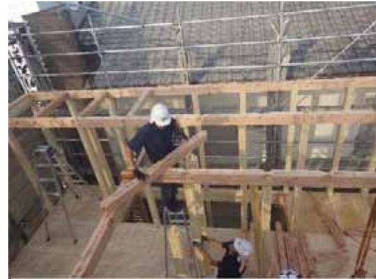
RF 小梁_人力取付
