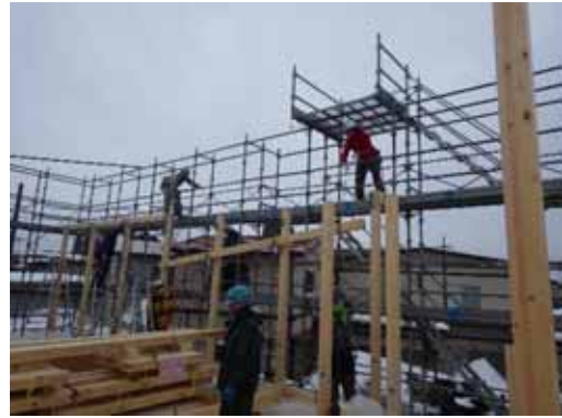
小屋梁_人力揚重
