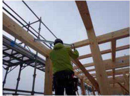
鋼製火打ち取付
