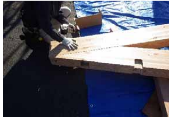
ボルト本締め(合掌尻部)
