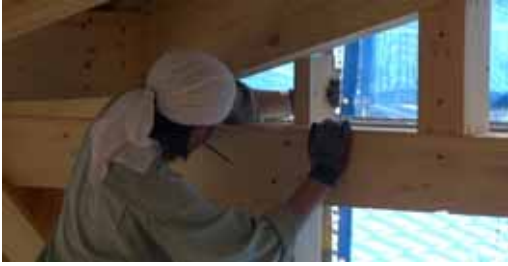
B部_間柱取付(大工B)
