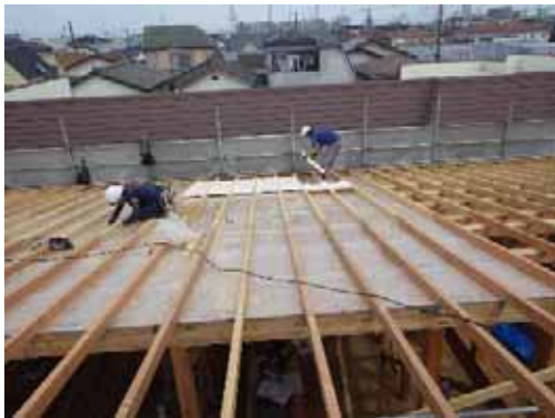
外断熱材敷き込み
