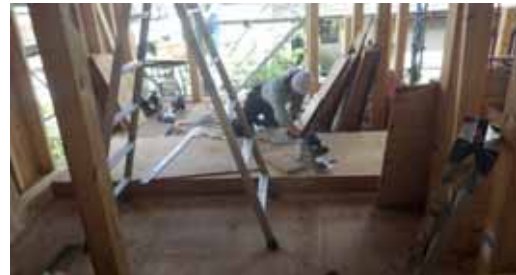
A部_面材加工(大工B)
