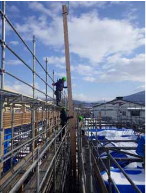
重量柱 揚重取付 (2)
