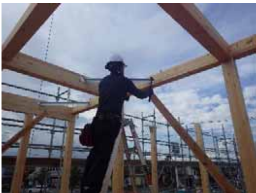
RF_火打ち金物取付
