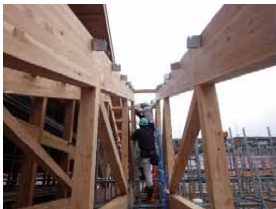
Tトラス 18-L-3 倒れ止め
