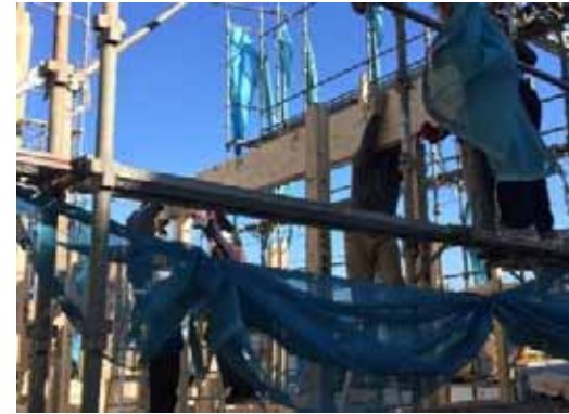
2F 床梁_人力揚重取付
