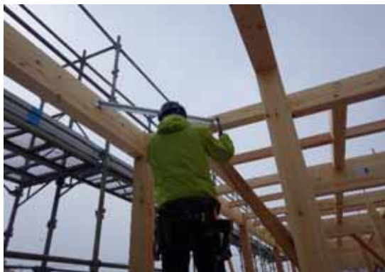
鋼製火打ち取付(非住 D)
