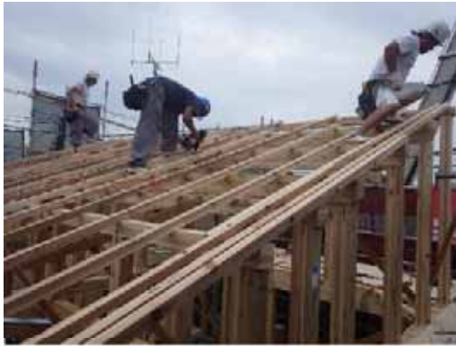
垂木取付(戸建 A)
