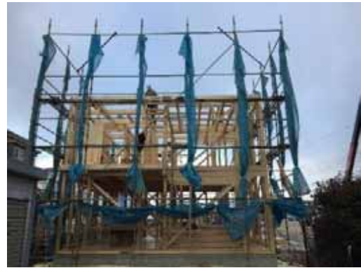
全景_小屋梁完了
