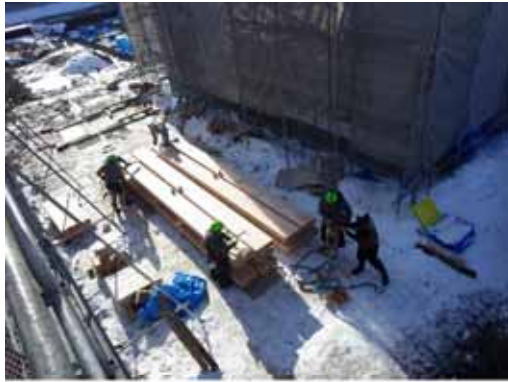
小屋梁(重量梁)資材ヤード平積み
