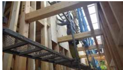
E部_面材取付(大工C)
