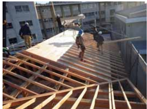
トラス合板上の垂木取付
