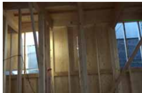
C部面材取付中
