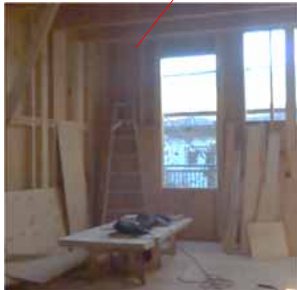
A部面材取付中
