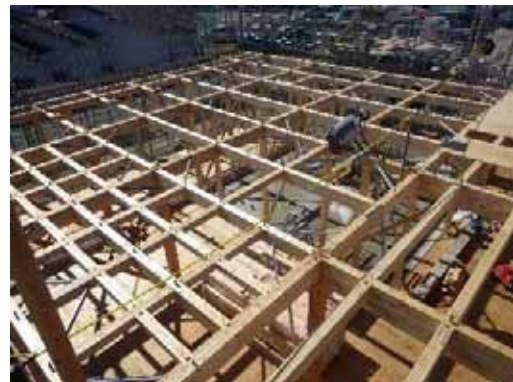
2F 火打ち_金物取付
