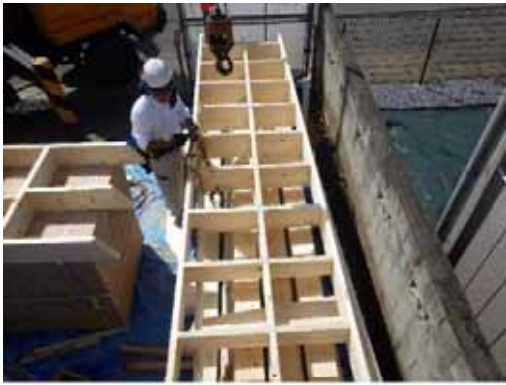
垂木ユニット_玉掛け
