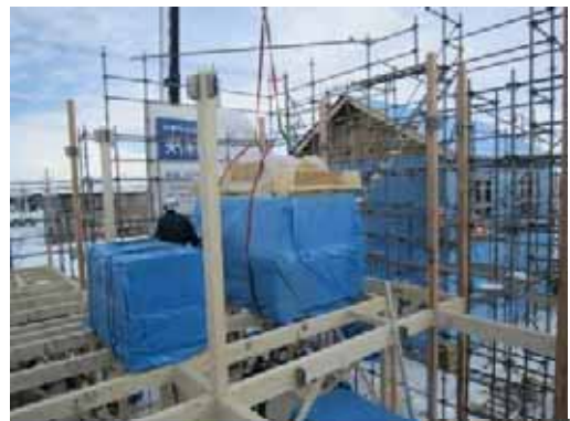
搬入_1F 壁パネル
