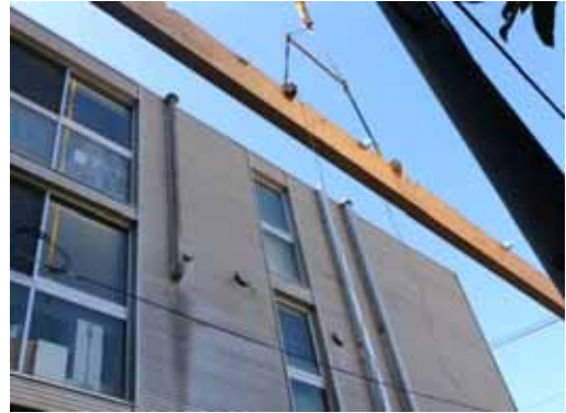
架空電線をよけて梁を揚重移動
