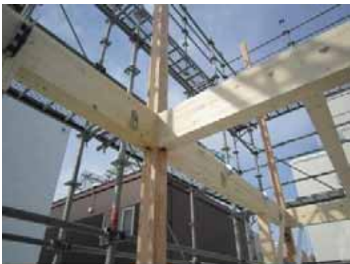
金物工法_柱梁接合部
