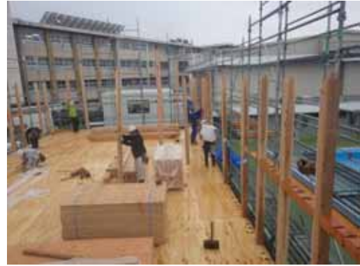
2F 柱_人力取付
