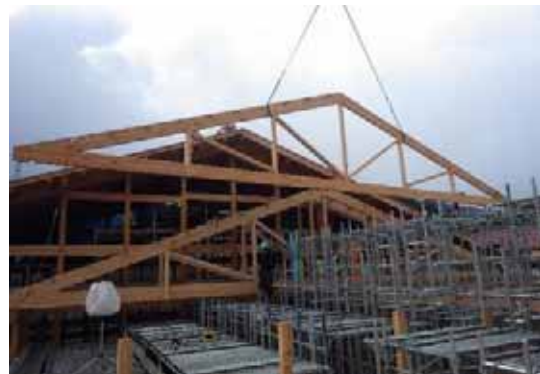
非常に大きいトラス
