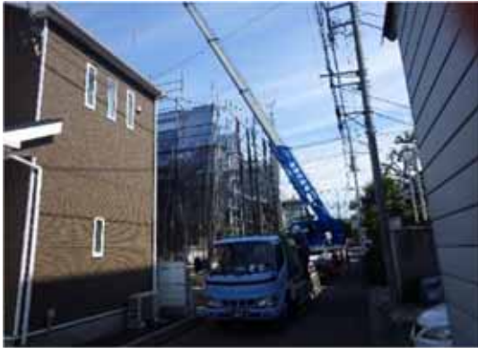
揚重機設置状況
