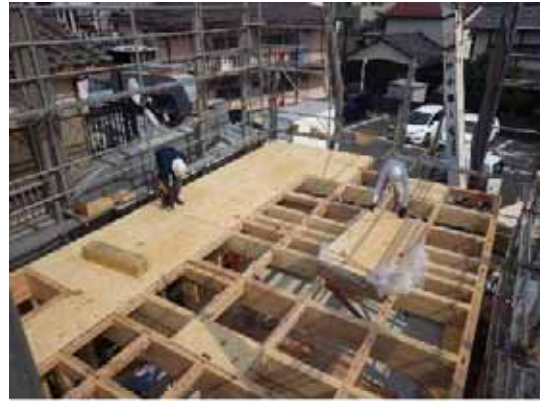
2F 床合板取付
