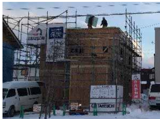
全景_建て方完了
