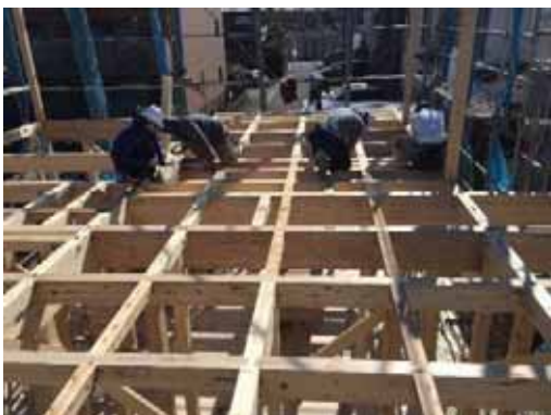
2F 梁接合_羽子板ボルト取付
