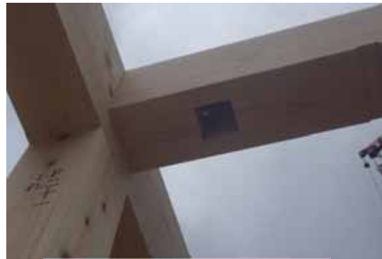
梁端接合_引きボルト
