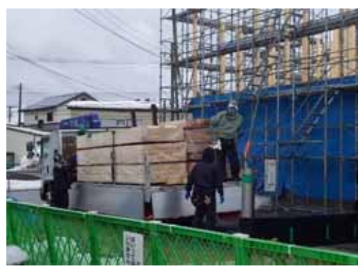
資材車載状況_羽柄(非住 D)
