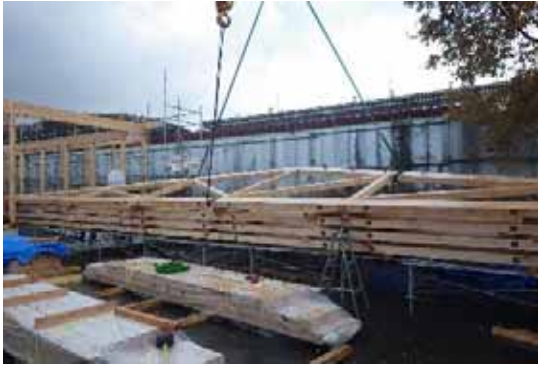
Tトラス 18-L-3 建て起こし
