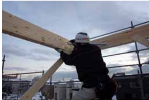
鋼製火打ち取付(非住 A)
