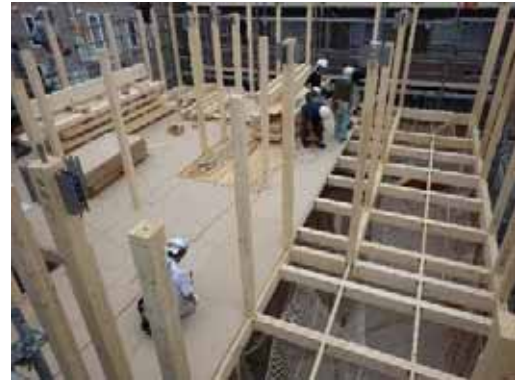
2F 床合板取付 (2)
