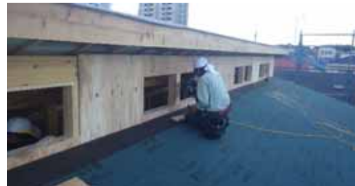
C部_壁合板貼付(大工B)
