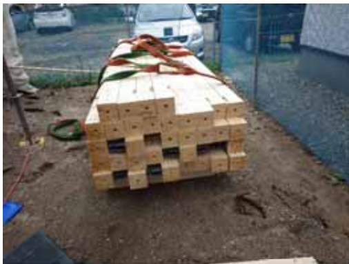
2F 柱玉掛け状況
