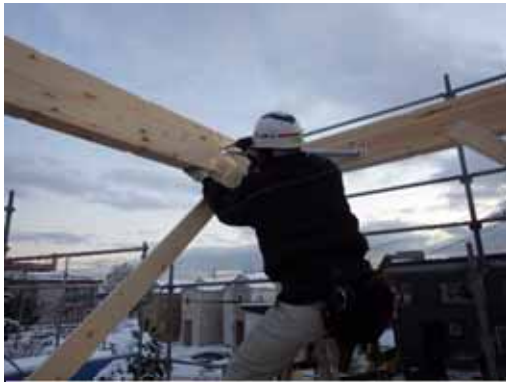
鋼製火打ち取付
