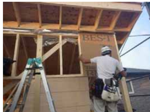
屋根境_壁面材先行取付
