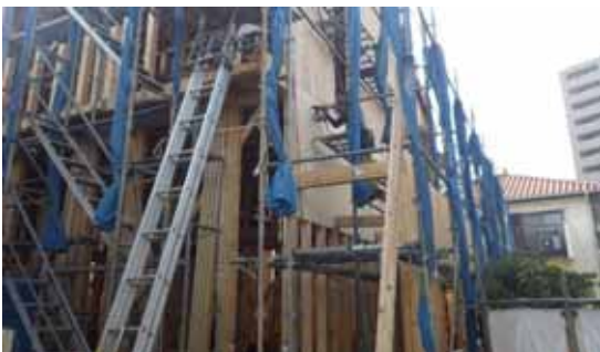
E部_面材取付(大工C)
