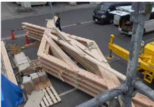
Rトラス 8-P-5 建て起こし
