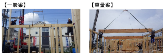
写1 一般梁と重量梁の取付状況
