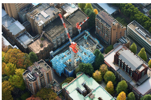
別館建設の様子を上空から（撮影 清水建設）
