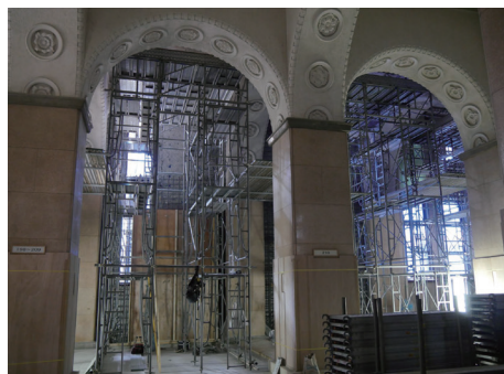
3階ホール工事の様子（撮影 清水建設）
