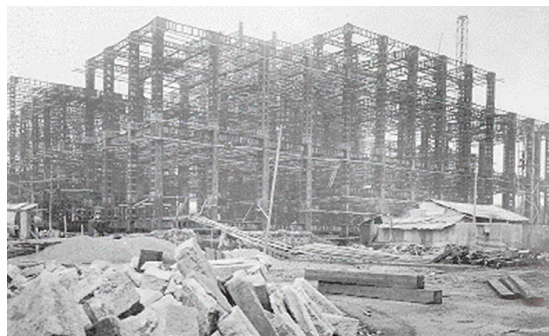
震災後の再建工事の様子
