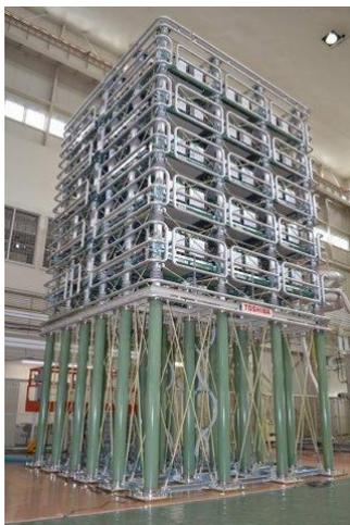
図 3.2: MMC 方式を適用した自励式変換器バルブ [17]
