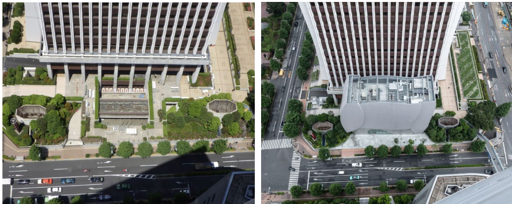
図4-7 損保ジャパン本社ビル公開空地の変化（左：改修前、右：改修後） 26
