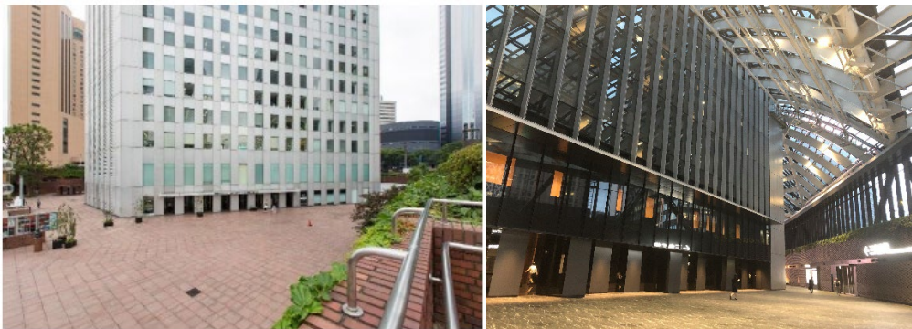
図 4-6 新宿住友ビルの公開空地の変化（左：改修前 23 、右：改修後 24 ）
