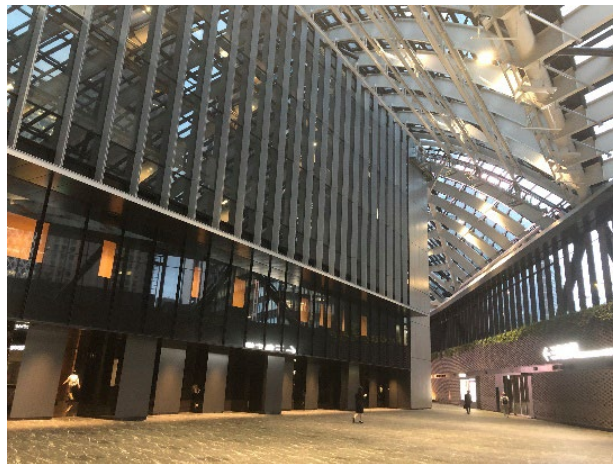
図1-2 屋根がかけられ屋内化された新宿住友ビル 10
