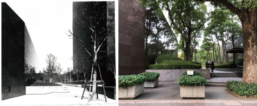
図 4-11 プランターが通路入口に設置された例（トヨタモビリティ東京） （左：変化前 36 、右：変化後 37 ）
