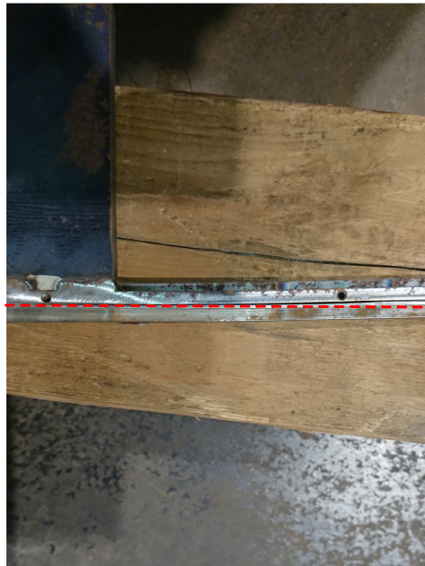
Fig.4.13 小型試験体の実験後の取付プレート周辺の様子
