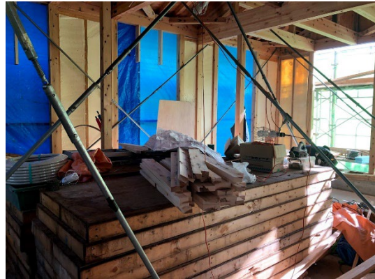
写真 23：移築工事の中の様子
