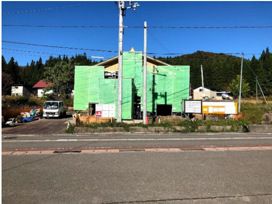
写真 22：移築工事の外観
