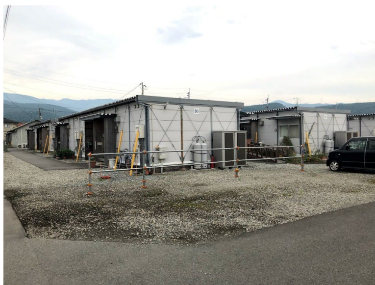
写真 12 : 1 棟 3 戸で建設されたプレハブ応急仮設住宅（小森仮設団地）
