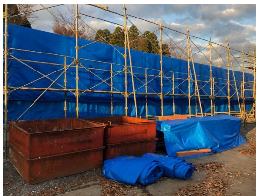
写真 26 : 移築後の様子
