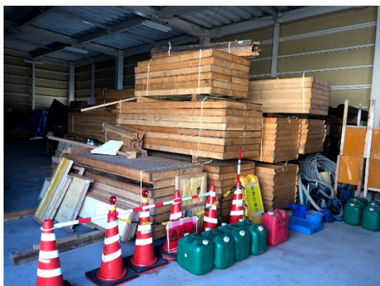
写真18：構造部材の保管
