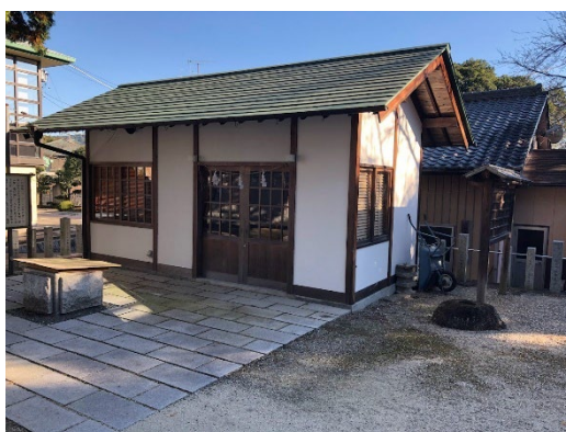
写真 30：移築再利用された資料展示室
