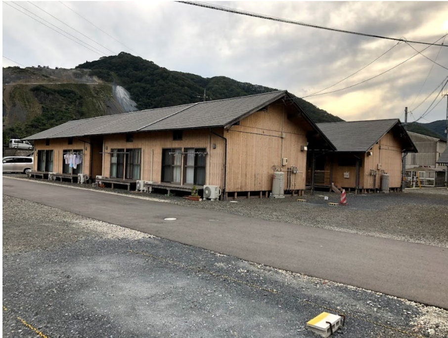
写真 29：事例 14 の再利用後の様子（西仮設団地）
