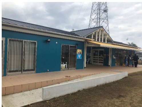
写真 32：ふれあい広場交流センター外観
