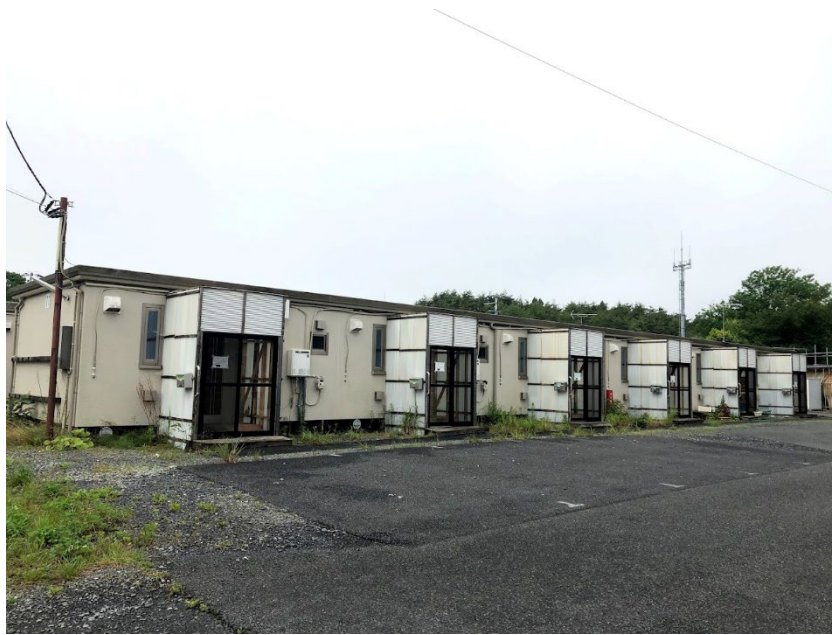
写真 5 : 東日本大震災で供給された鉄骨ユニット構法の応急仮設住宅 (宮城県南三陸町)
