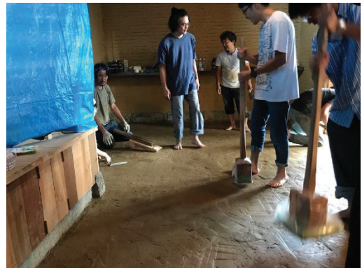
図 2-3-11-e 耕運機で土と稲藁を混ぜる施主の山口（左） 98 と土間打ちの様子（右写真は筆者撮影）
