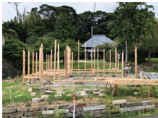
図 3-2-1-j 石造の蔵の石材を再利用した石場建ての基礎と外構（写真提供：高木俊）
