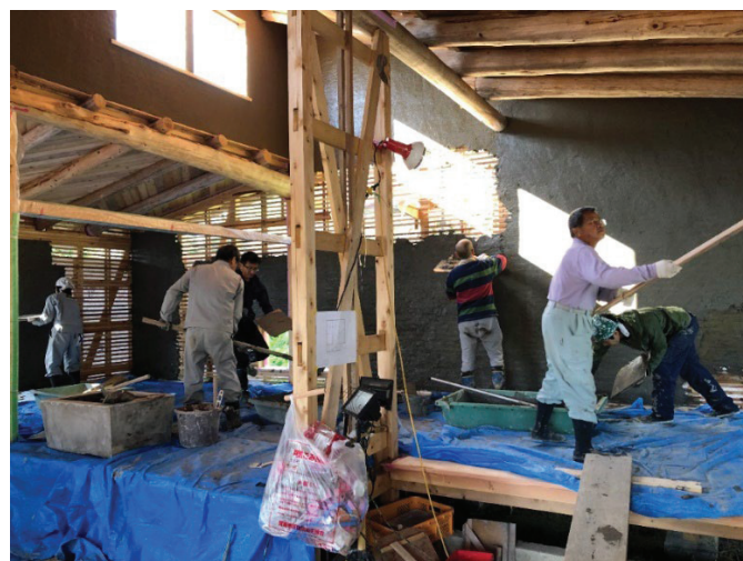
図 3-2-1-m 発酵土づくりと土壁塗りワークショップ
