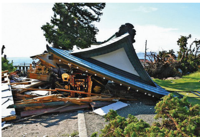
図 3-2-1-p 倒壊した神輿蔵 (東京新聞より 150 )
