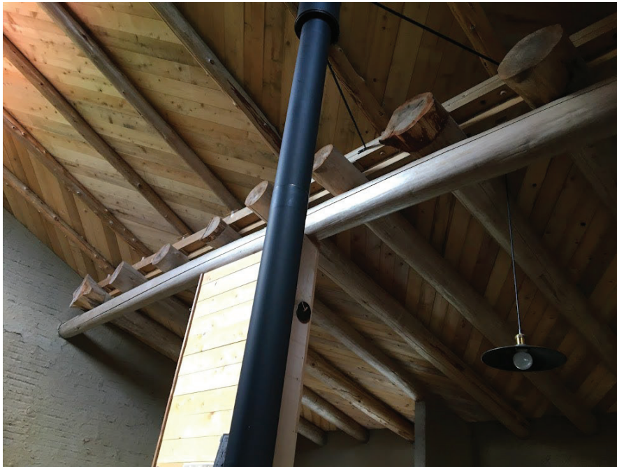
図 2-3-11-a 間伐材を生かしたハウスモンクビートの屋根架構（筆者撮影）
