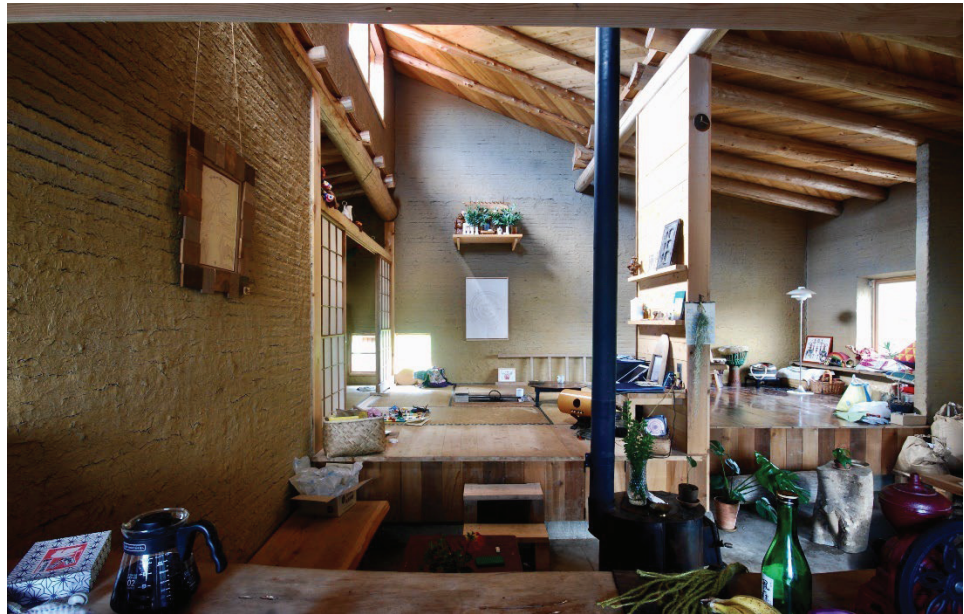
図 2-5-4-a ハウスモンクビートの外観と内観。丸太材を架構に用いた屋根が特徴的である
