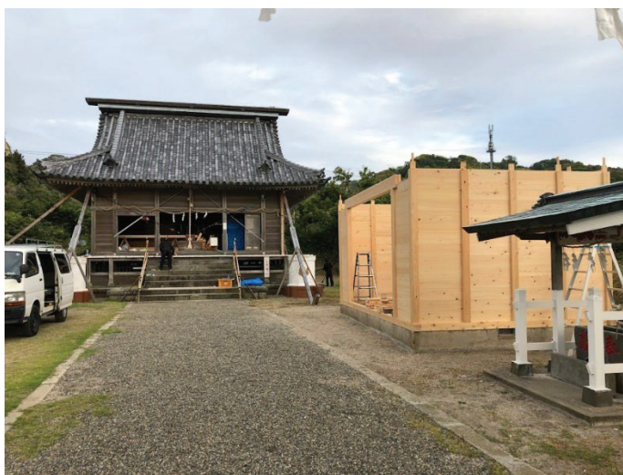
図 3-2-1-q 仮設的な衝立に支えられる本殿と再建途中の神輿蔵 (筆者撮影)
